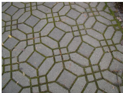
Figuur 4: bestrating met open voeg.
