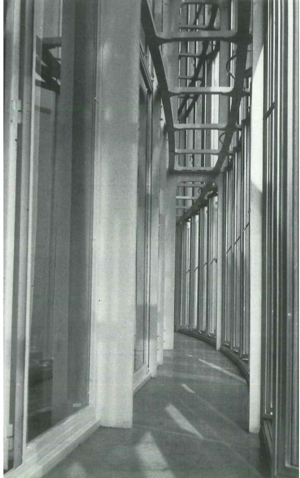
Afb. 34 De aluminium ramen moesten vervangen worden. Binnen-en buitenramen waren 90 centimeter van elkaar verwijderd en verbonden door een stalen constructie die tegelijkertijd het dragende element vormde.
