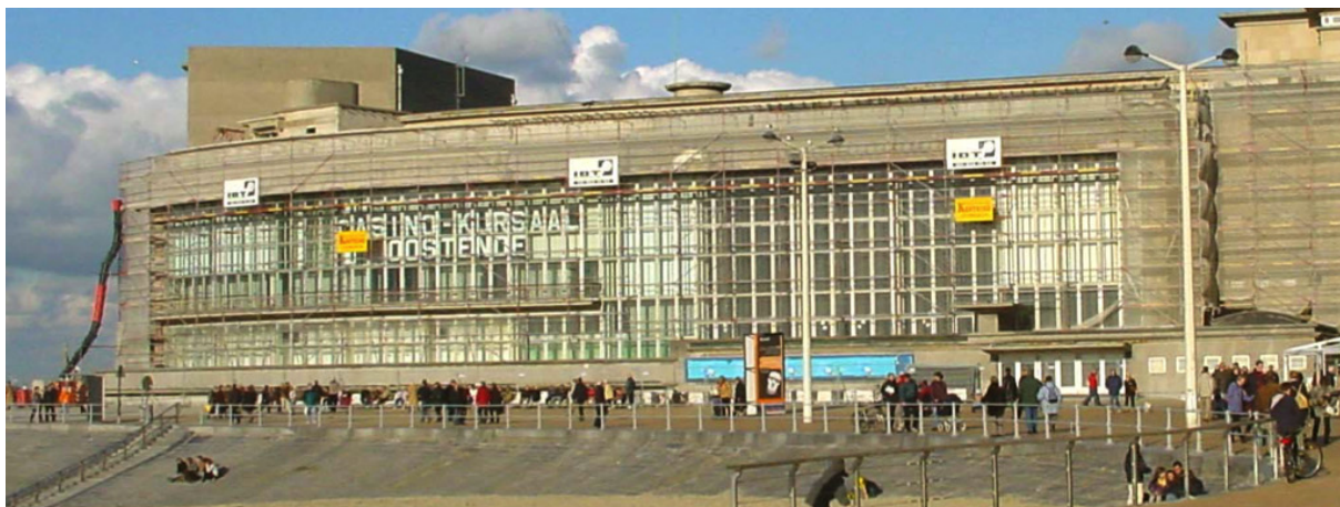
32 Afb. 28 De 'lompe doos' die op het bouwvolume werd geplaatst, is zichtbaar op de onderste foto. Momenteel is het restaurant 'The Ostend Queen' er gehuisvest.
