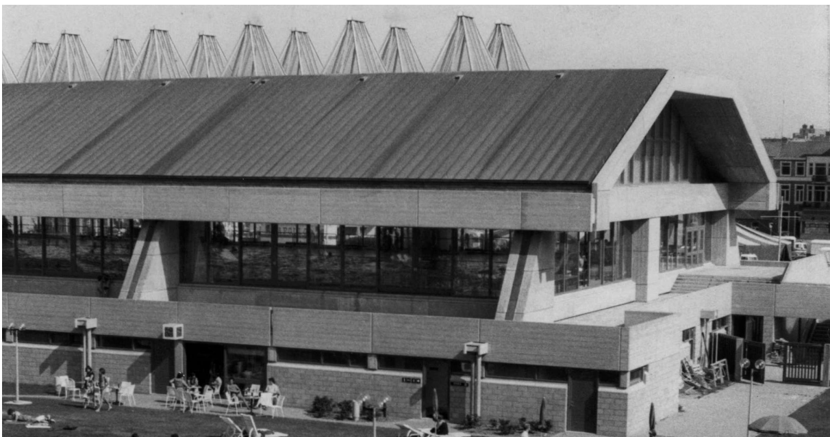
Afb. 46 Het stedelijk zwembad en zijn opvallende dakstructuur.
