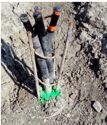
Foto 14: Energiepaal met dubbele lus
