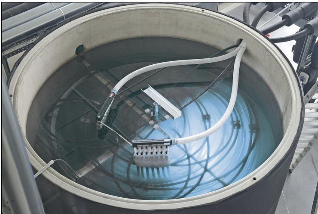
Figuur 7 Ijsbuffervat in gevulde staat (Bron: www.ikz.de )
