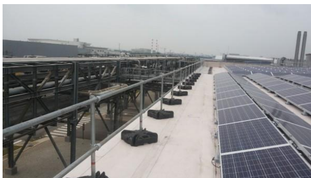
Figuur 4.40: voorbeeld dakreling (Simplified Safety, s.a.)
