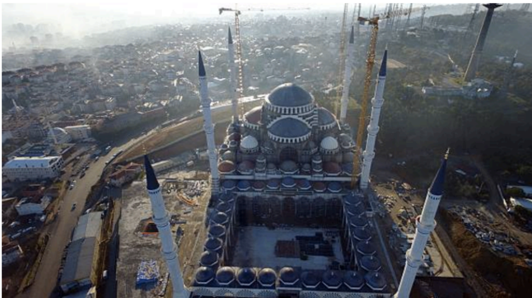
Afb. 13: De Çamlıca Camii vanuit de lucht bekeken (bron: gettyimages).
