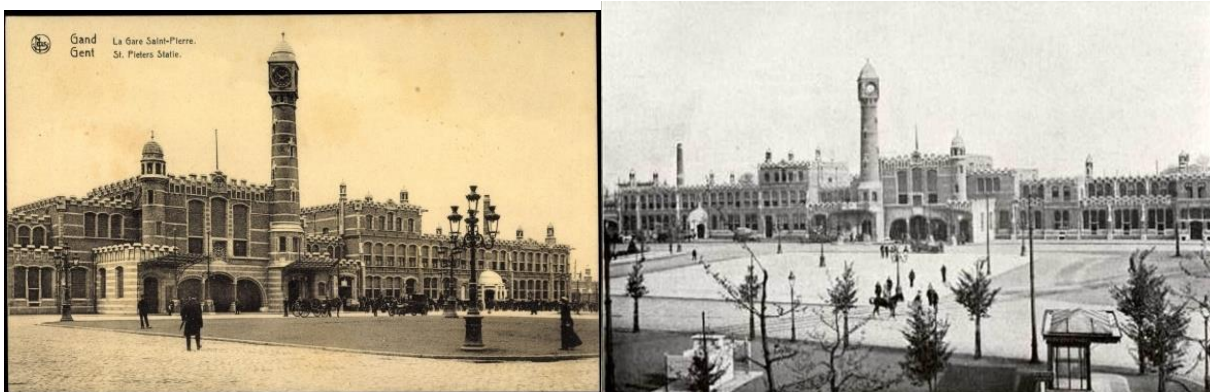
Figuur 3: Station 1916 (Google, 2017)
