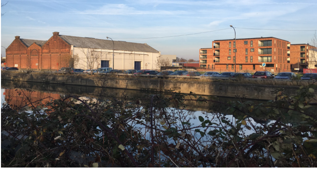
IV. 50-A: Woonontwikkeling 'Pier Kornel' op de voormalige Tupperwaresite, Aalst
