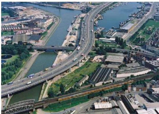
Afb. 47 Ten oosten van het Eilandje zal de Oosterweelverbinding aansluiten op de Antwerpse ring. Vandaag ligt daar nog het viaduct van Merksem, dat onder de grond zal verdwijnen om een overkapping mogelijk te maken.
