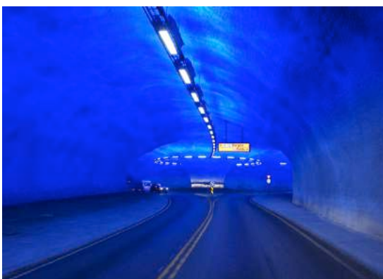
Afb. 58 De Buttunneln tunnel in Noorwegen is een voorbeeld van de ingenieuze Noorwegse tunneltechniek. Een rondpunt in de berg verbindt drie tunnelarmen.
