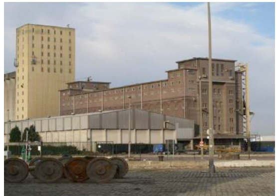
Afb. 46 De SAMGA-silo's net ten noorden van het Noordkasteel mogen vanaf 1 oktober 2016 gesloopt worden voor de bouw van de Oosterweelverbinding. De actiegroepen proberen deze stadsiconen alsnog te redden.
