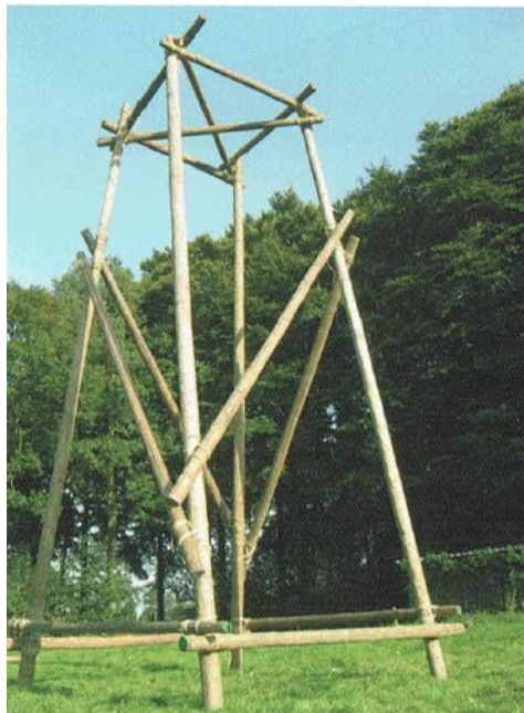
Figuur 7-4 : foto van een torenconstructie (Pollefoort et al., 2009).
