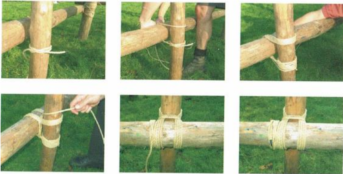
Figuur 2-4 : stapsgewijze opbouw van de kruissjoring (Pollefoort et al., 2009).
