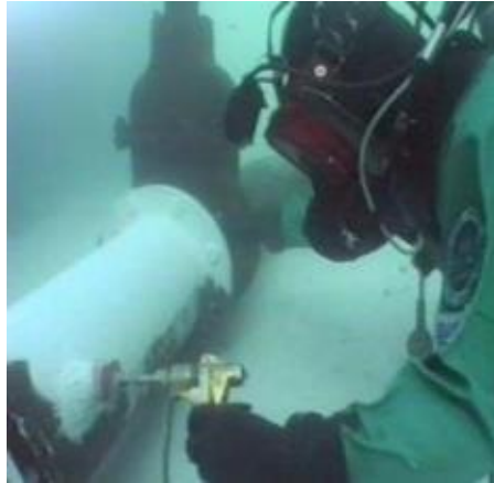
Figuur 58: Coating onder water aanbrengen m.b.v. handpomp systeem (Energy Coating, z.d.)
