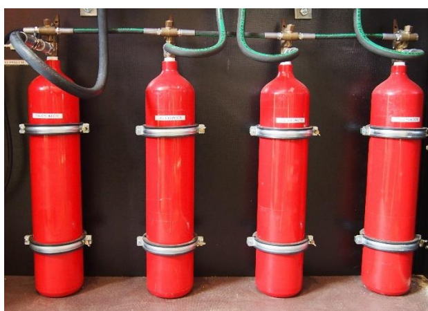
Figuur B3 Vier CO 2 -cilinders met kleppen Bron: eigen werk
