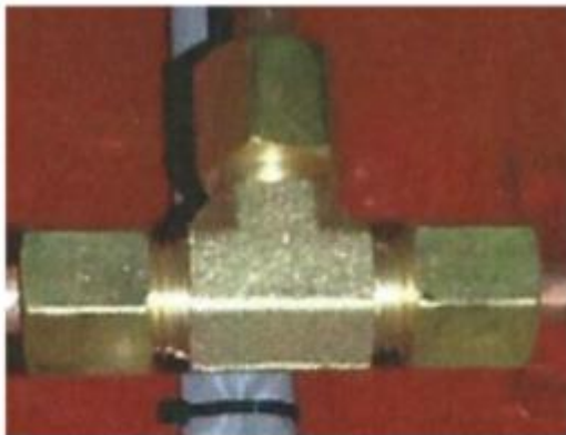
Figuur B13 T-stuk voor koperen pijpleidingen Bron: Tyco Seaplus (2014)
