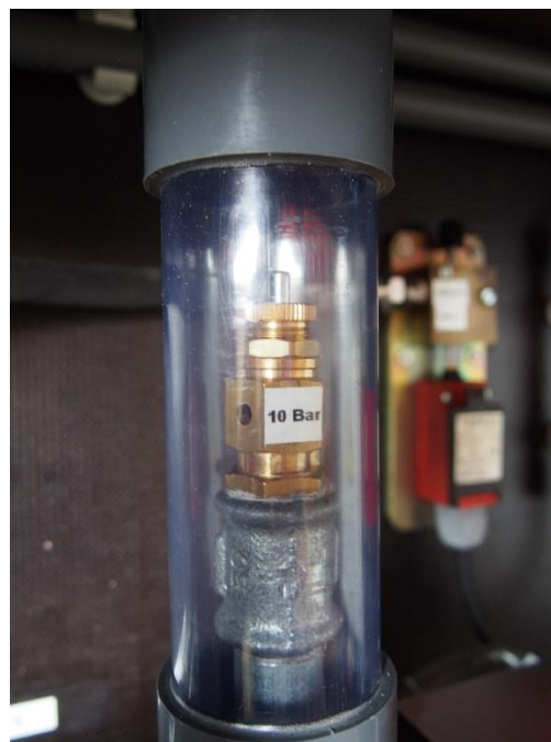
Figuur B18 verlosklep Bron: eigen werk
