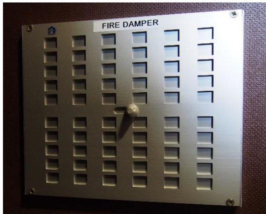
Figuur B21 Branddemper Bron: eigen werk
