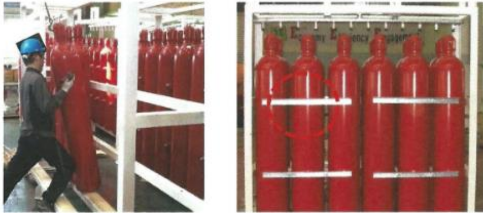
Figuur 8 CO 2 -cilinders met houten rooster, in rijen van twee Bron: Tyco Seaplus (2014)
