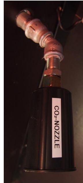
Figuur B20 CO 2 -spuitmond Bron: eigen werk
