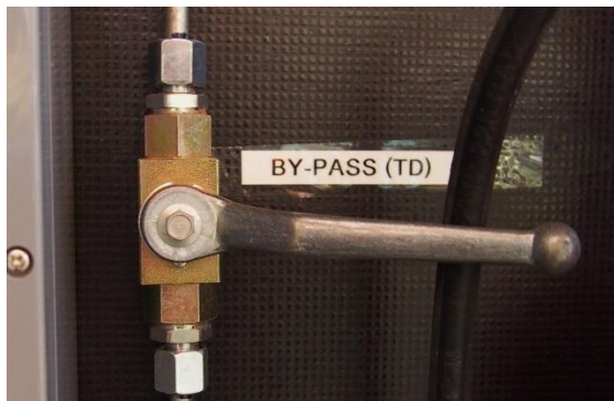
Figuur B15 Bypass valve Bron: eigen werk
