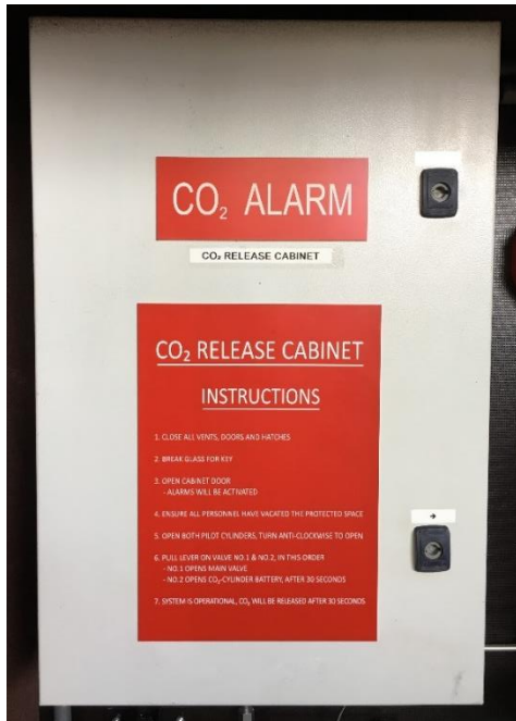
Figuur 20 CO 2 -bedieningspaneel Bron: eigen werk
