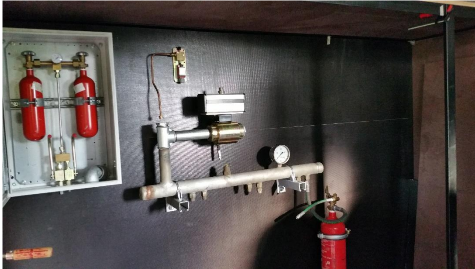
Figuur 15 Installatie van de eerste onderdelen Bron: eigen werk
