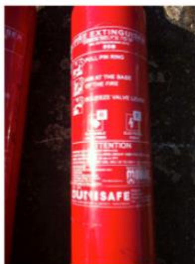
Figuur B4 CO 2 cilinder met opschrift Bron: eigen werk
