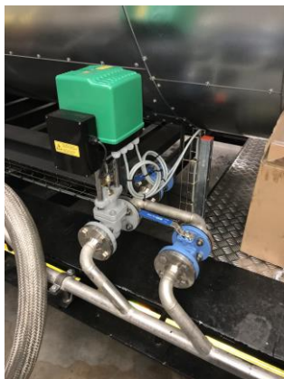
Figuur 49: Automatische bodemspui
