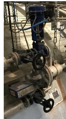
Figuur 28: Geleidbaarheidssonde met oppervlaktespui
