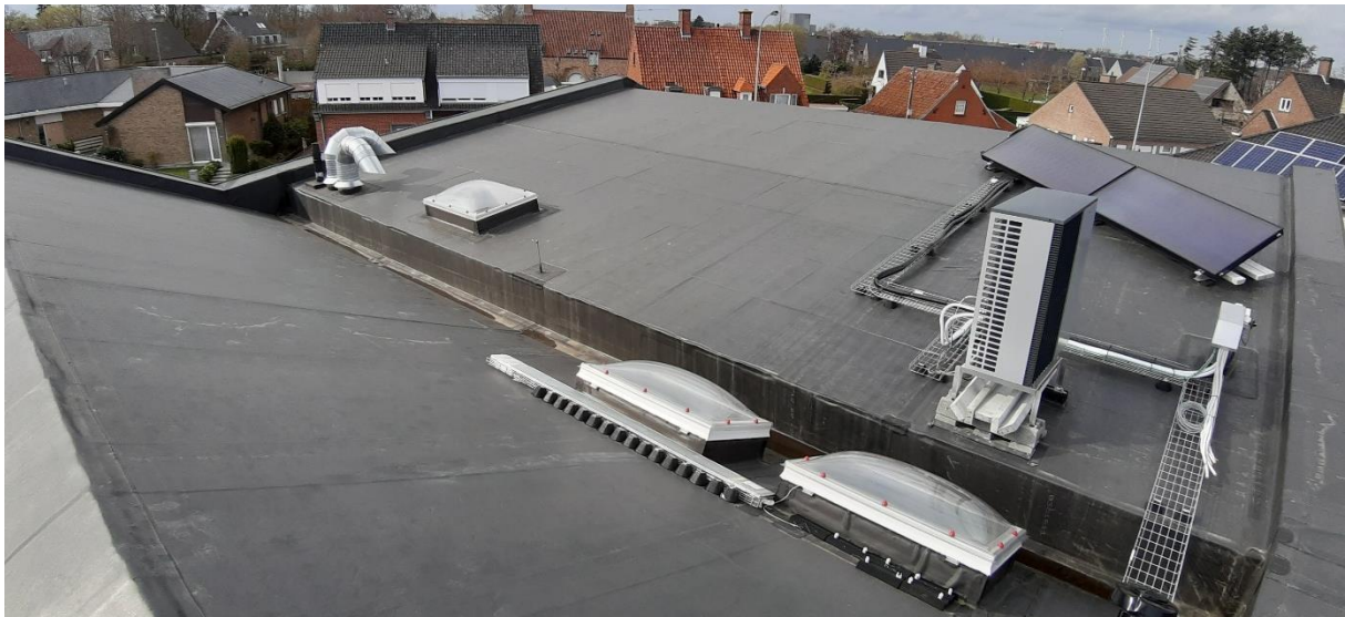
Figuur 36: Dak DTplan, met rechts de fothermische panelen en buitenunit van de warmtepomp [35]
