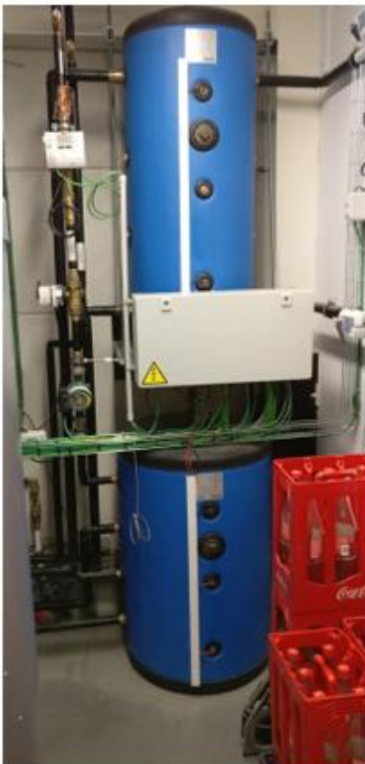
Figuur 35: De luchtgroep (linksboven), de technische ruimte in het atelier met de warmtepomp (rechtsboven) en het warm en koud buffervat (linksonder) en de vergaderzaal (rechtsonder)
