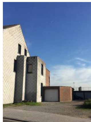
Fig. 18: Blinde gevel van een rijhuis in Hemiksem Eigen beeld
