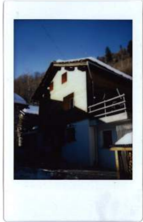
MONTACCIO @ FEB 15u15 "nu de woning van mijn -tante's nakkelt" ↳ isolatie binen & buiten + nieuwe gevel
