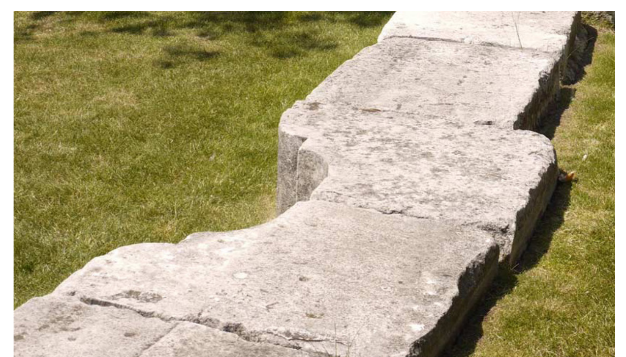
Bijvoorbeeld in afbraak Brusseliaanse kalksteen als zit- en keermuur [Foto: Townshend-landscape Architects]
