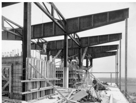
Afb 27 – De opbouw van de ophangoconstructie.
