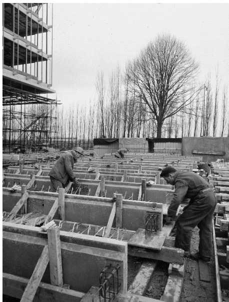
Afb 26 - Constructie van de ondergrondse verdieping.
