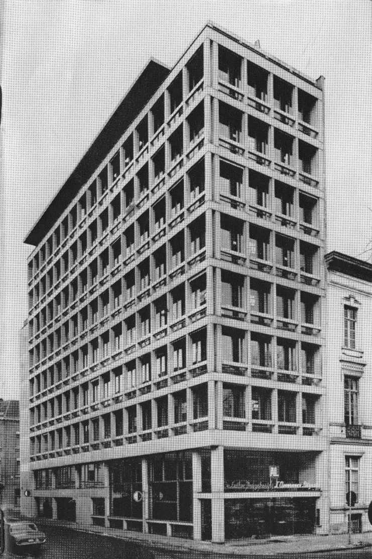
IMMEUBLE POUR BUREAUX AVENUE DE FRANCE, A ANVERS
