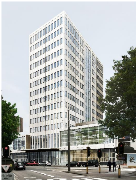
Afb 23 – De gerenoveerde E.B.E.S.-toren kreeg een nieuwe naam: WATT toren.
