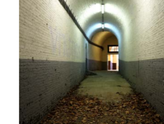
Doorgang gelijkvloers, eigen beeldmateriaal
