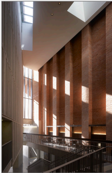
Figuur 10: Foyer; links: betonnen muren; rechts: bakstenen muren
