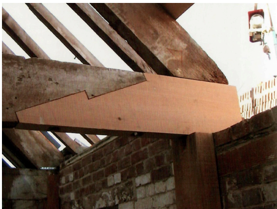
Afb. 21: Balkkopprothese van nieuw hout met schuine haaklas. (McCaig, I., p. 296)
