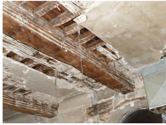
Bijlage afb. 72: Voormalige eetzaal niv. 0 met verwijderd pleisterwerk van moerbalken (Origin, 2016).
