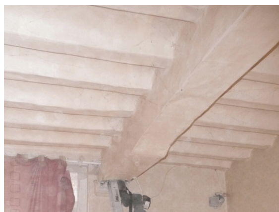
Bijlage afb. 23: Woning 2, niv. 1, bestaande toestand, bepleisterde moorbalk en kinderbalk met troggewelven (Triconsult, 2010).
