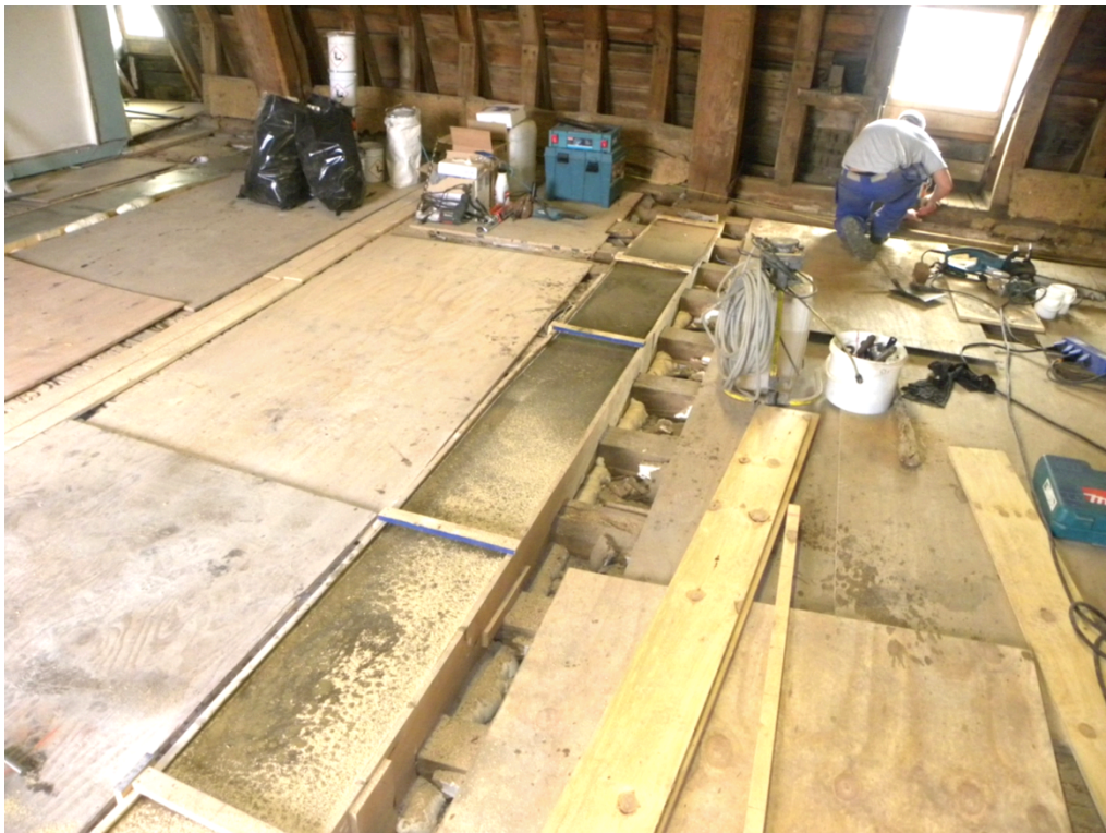
Afb. 42: Verstevigde moerbalk d.m.v. opgegoten epoxymorteluitvulling van een bepaalde dikte. Uithardingsfase in bekisting. Zoldervloer Westvleugel, Abdij van Park (Heirman, G., p.253).
