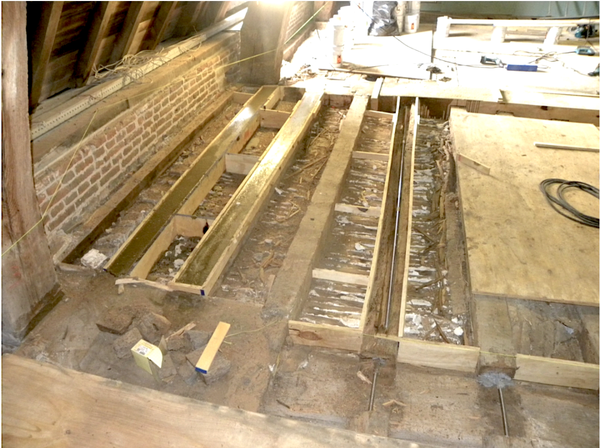
Afb. 27: Zoldervloer westvleugel Abdij van Park. Herstelde kinderbalken met epoxymortel. Links bekistingen rond de kinderbalken en uithardende epoxymortel, midden behouden kinderbalk, rechts zichtbare wapeningsstaaf (inox draadstang) (Heirman, G., p.250).
