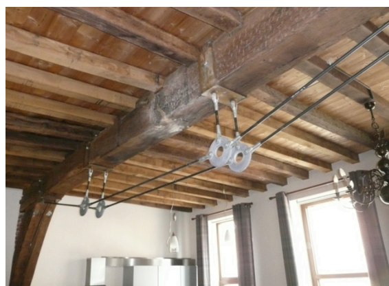
Afb. 29: Opspannen van de moerbalk met stalen trekkers (Grote Markt, Diest, Heirman, G.)
