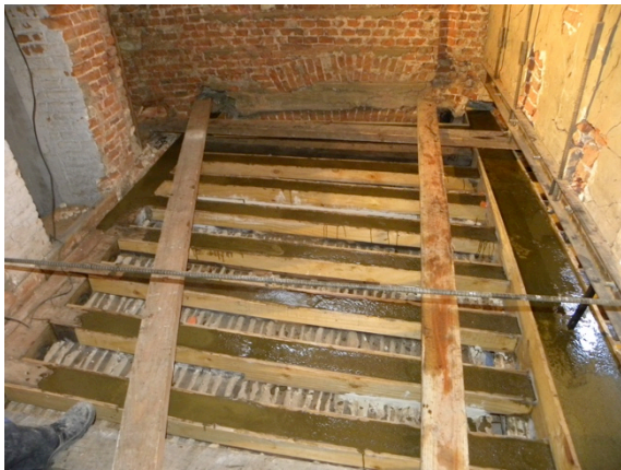
Bijlage afb. 62: Herstel en versteviging van de kinderbalken met epoxymortel na het afkappen van slechte delen (Triconsult, 2014).
