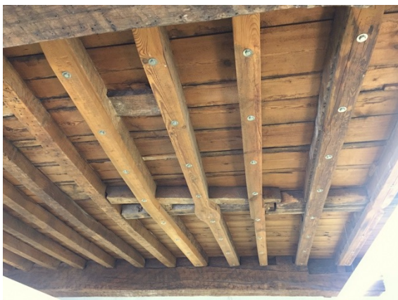
Afb. 34: Verstevigde kinderbalken met opgelijmde houten secties. Kartuizerstraat 31, Brussel (auteur, 2019).
