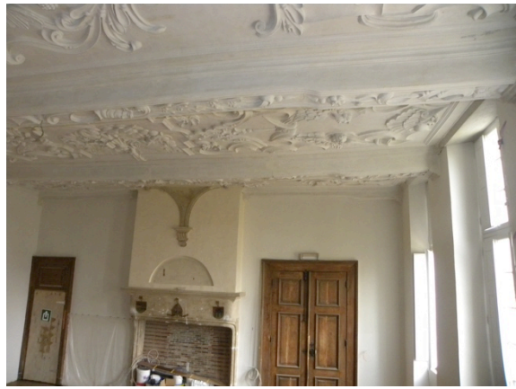
Bijlage afb. 44: Stucplafond vloer niv. 1 (Triconsult, 2013).
