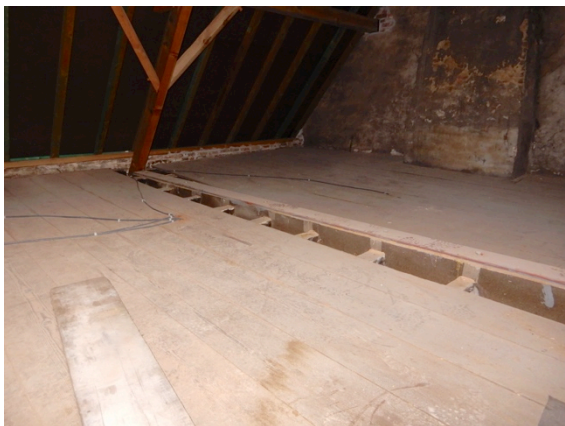
Bijlage afb. 4: Epoxyuitvulling en staalplaat (Triconsult, 2017).
