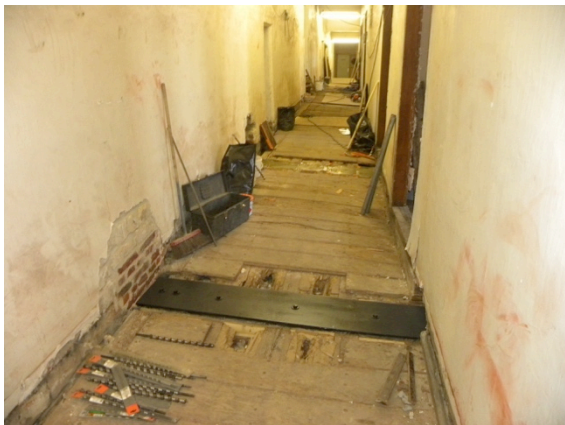
Bijlage afb. 58: De staalplaten werden onder de muur door op de moerbalk bevestigd. (Triconsult, 2014).
