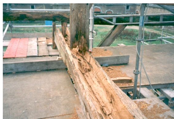
Afb. 24: Stap 1: verwijderen van aangetast hout (Heirman, G., p.300)
