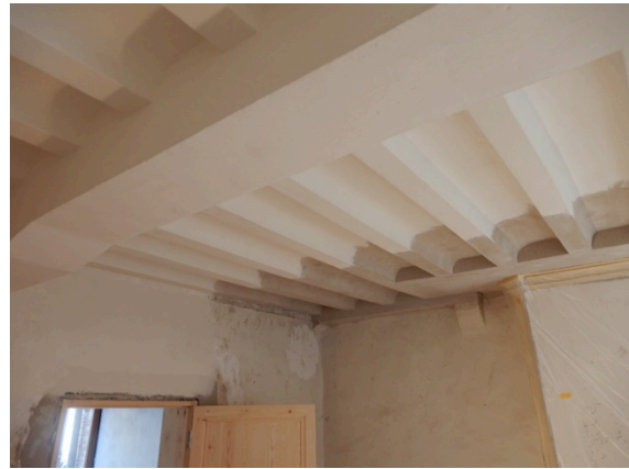
Bijlage afb. 25: Woning 4, niv. 1, werken in uitvoering (gelijkaardig aan woning 2) (Triconsult, 2010).
