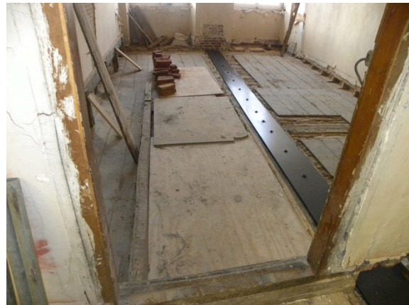
Bijlage afb. 57: Versterken van een moerbalk van vloer niv. 1 met staalplaat op epoxymorteluitvulling. De dikte van de staalplaat is beperkt dankzij het verlagen van de in te rekenen mobiele belasting t.o.v. de norm (Triconsult, 2014).
