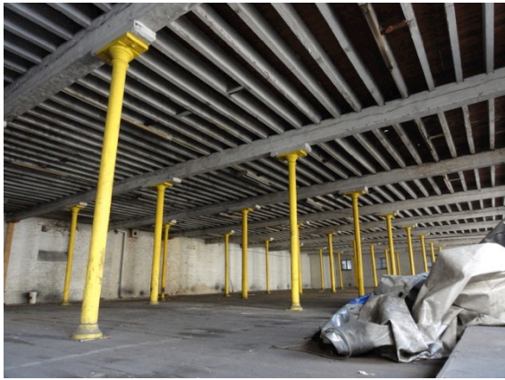
Afb. 77: Houten vloerstructuur in Brussels pakhuis eind 19 de eeuw (L. Vandenabeele, 2014)
