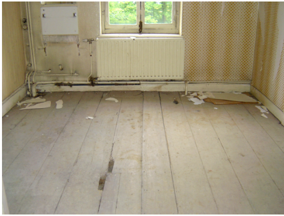
Bijlage afb. 71: Eikenhouten plankenvloer niv. 1 (A. Vermijlen, 2006).
