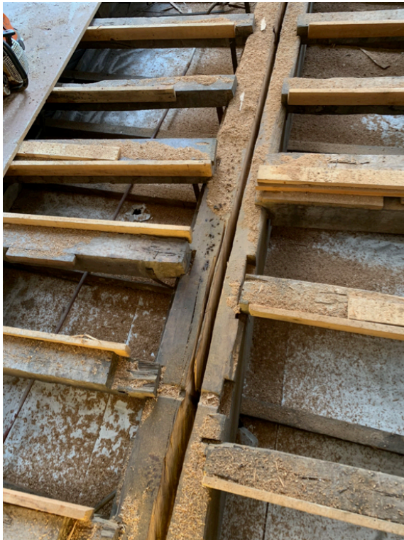
Bijlage afb. 35: Stap 1 na vrijlegging: geslepen gleuf in moerbalk voor het inlijmen van staalplaat (DDS+, 2019).
