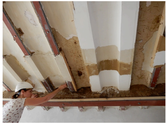
Bijlage afb. 18: Woning 8, niv. 1, tijdens interventie, reconstrueren van de bepleistering op de staalplaten met wapeningsnetjes (Triconsult, 2017).
