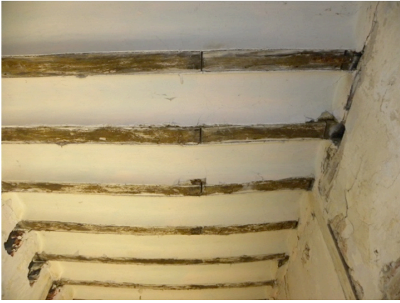
Bijlage afb. 15: Woning 8, niv. 1, tijdens interventie, vrijlegging van de onderzijde van de kinderbalken, met maximaal behoud van troggewelven (Triconsult, 2017).
