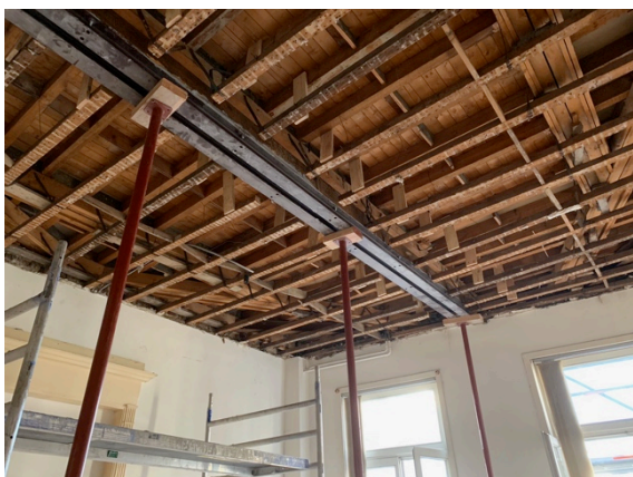
Afb. 48: Toevoegen van HEA 100 profielen onderaan een moerbalk – case B.II (MRT, 2019).
