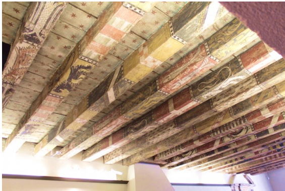
Afb. 2: Enkelvoudige balkenlaag van (verplaatste) middeleeuwse vloerconstructie met kleine hart-op-hart-afstand en polychrome beschildering, Musée de La Cour d'Or, Metz (auteur, 2019).
