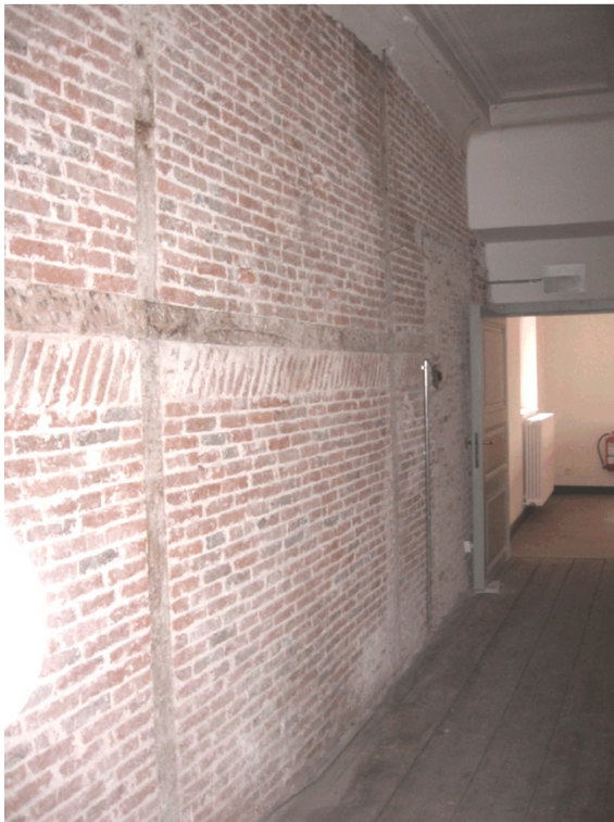
Bijlage afb. 52: Regelwand op niv. 1, ontdaan van bepleistering om de opbouw te kennen: houten stijl- en regelwerk met metselwerkinvulling (Triconsult, 2009).
