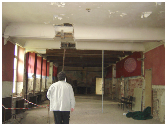
Bijlage afb. 68: Voormalige eetzaal niv. 0, sonderingsopeningen (A. Vermijlen, 2005).
