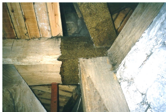
Afb. 18: Epoxymortelherstelling zonder verloren bekisting, St.-Catharinakerk Duisburg (Heirman, G., p.169).
