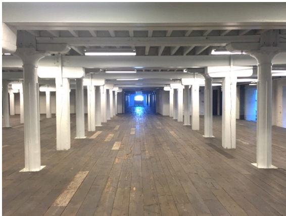
Afb. 81: Combinatie hout en staal, Felixpakhuis, Antwerpen, 1858. Eind 19 de eeuw werden gewalste stalen I-liggers op houten sloefen en kolommen toegevoegd ter versteviging van 900 naar 1200 kg/m 2 (auteur, 2016).
