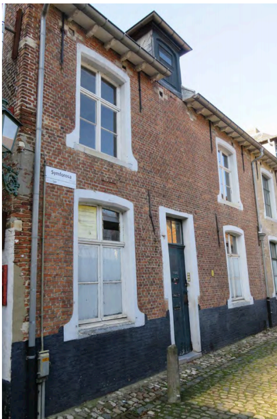
Bijlage afb. 2: Woning 12, bestaande toestand, voorgevel (BvdW & Sumproject, 2017).
