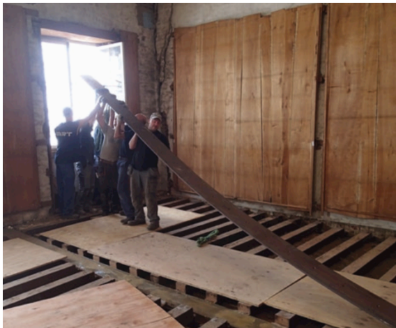
Afb. 38: In positie leggen van staalplaat aan de bovenzijde van de te versterken moerbalk, veel helpende handen (WTCB, 2015).
