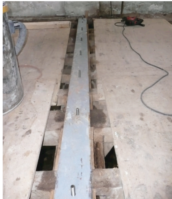
Afb. 39: Staalplaat met ingelijmde knikverstijvers (WTCB, 2015).
