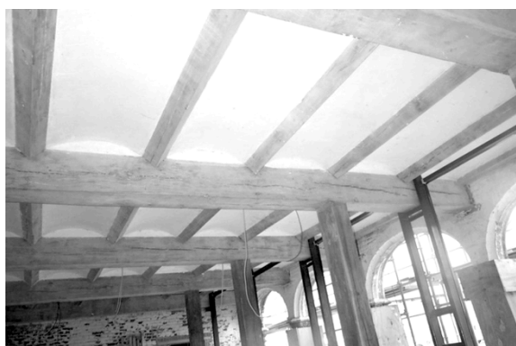
Afb. 28: Toegevoegde houten kolommen in 1967, onder moerbalken die bakstenen troggewelfjes ondersteunen. Deze werden tijdens de restauratie vervangen door stalen kolommen ingewerkt in het buitenschrijnwerk. Koetshuis Abdij van Park (Triconsult, 2005).
