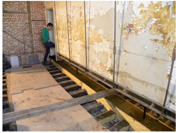
Bijlage afb. 61: Ophanging van de dragende wand boven het Hansche stucplafond aan de bovenliggende moerbalk, teneinde de versteviging van de onderliggende te kunnen uitvoeren (Triconsult, 2014).
