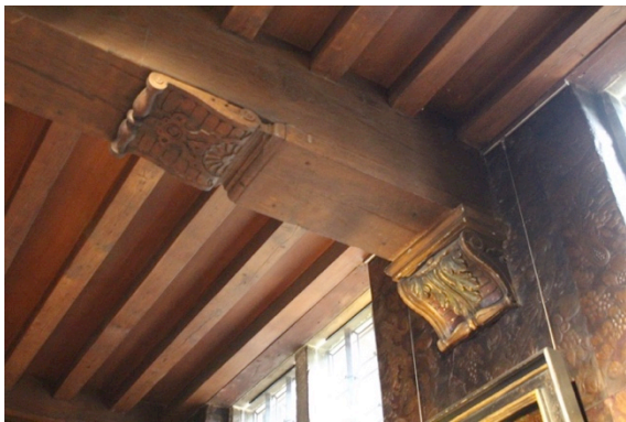
Afb. 11: Moer- en kinderbalkenvloer met uitgehouden en beschilderde balkkop en console, Rubenshuis, Antwerpen, 1610-1621 (auteur, 2019).
