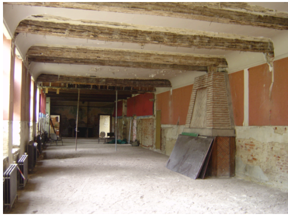
Bijlage afb. 70: Voormalige eetzaal niv. 0, verwijderd pleisterwerk van moerbalken (A. Vermijlen, 2006).
