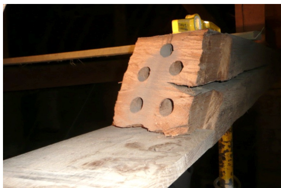
Afb. 17: Behouden gedeelte van de moerbalk met ankerholtes voor de structurele verbinding met de te storten epoxymortel, pandgang basiliek Tongeren (Heirman, G., p.172).
