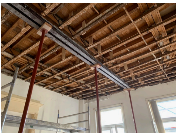
Bijlage afb. 41: Twee HEA 100 profielen geplaatst onder moerbalk niv. 2 (DDS+, 2019).
