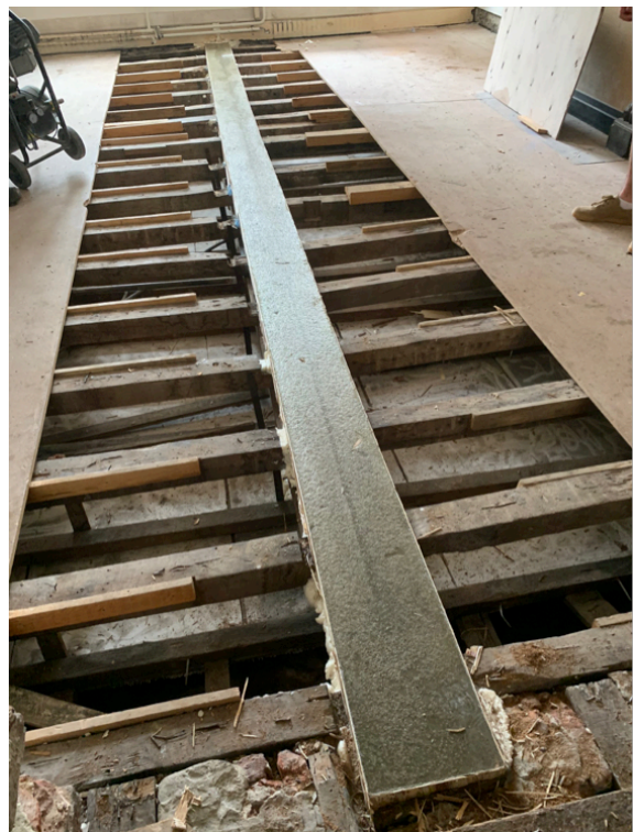
Bijlage afb. 38: Stap 4: epoxymorteluitvulling, bekisting weggehaald: moerbalk is opgehoogd met 4 cm. Hout en epoxy werken samen (DDS+, 2019).
