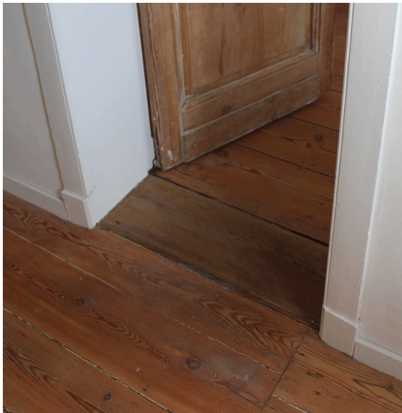
Afb. 75: Verdiepingsvloer met lange brede eikenhouten planken, zeer gaaf bewaard. Hal naar slaapkamer. Voormalige Berg van Barmhartigheid, Antwerpen (auteur in kader van beheersplan door Maat_werk architecten, 2017).
