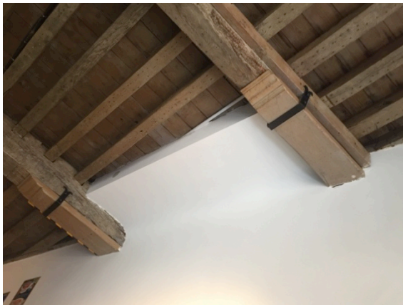
Afb. 69: Historisch pand Hendrik Conscienceplein 11, Antwerpen, ca. 1550-1650. Beschermd als bouwkundig erfgoed sinds 29-03-2019 (auteur, 2019).
