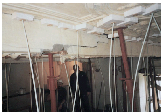
Afb. 58: Tijdelijke ondersteuning van het stucwerk met polystyreenplaatjes en flexibele glasvezelstaven (Laboratorium Reyntjens, 1995).
