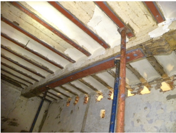
Bijlage afb. 17: Woning 8, niv. 1, tijdens interventie, toevoegen van stalen platen onderaan kinderbalken en moerbalk; aansluiting met balksleutel (Triconsult, 2018).
