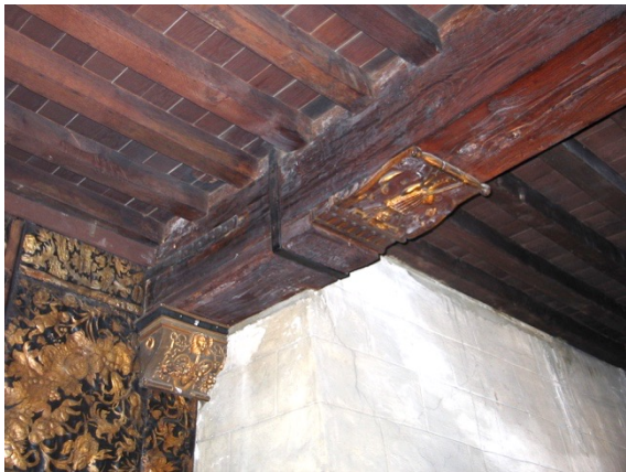
Afb. 66: Uitgehouden en vergulde sleutelplank en balkconsole in aansluiting met goudleer. Brouwershuis Antwerpen niv. 1, vloer niv. 2 (Maat_werk architecten, 2010).
