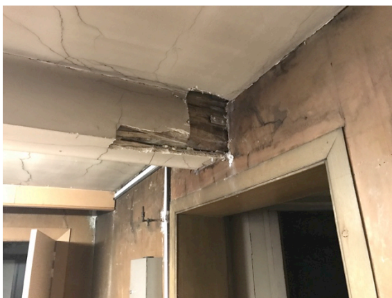
Bijlage afb. 31: Sondering balkkop vloer niv. 4 (Origin, 2018).
