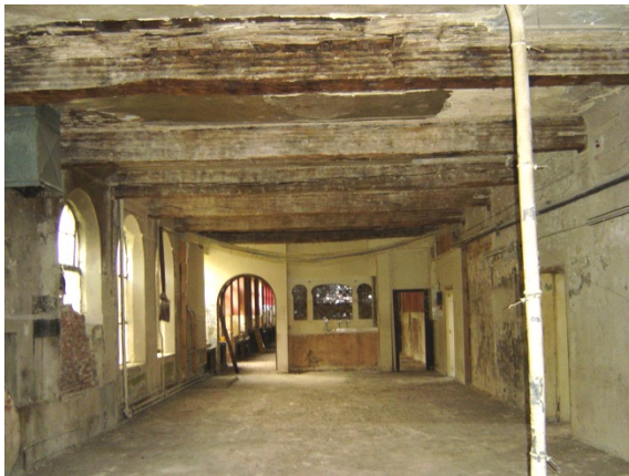
Bijlage afb. 69: Kapittelzaal niv. 0, alle historisch pleisterwerk verwijderd (A. Vermijlen, 2006).
