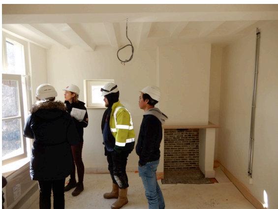
Bijlage afb. 6: Woning 12, niv. 1, nieuwe toestand, na toevoegen van een staalplaat onderaan de moerbalk, bepleisteren van de moerbalk en bijkomend vernagelen van de plankenvloer met de kinderbalken (Triconsult, 2018).
