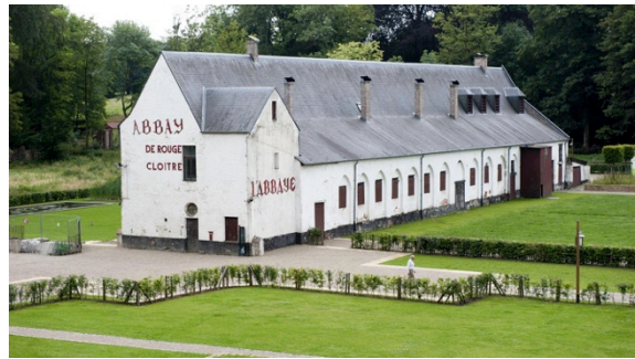
Bijlage afb. 66: Noord- en westgevel van de priorij (La Meuse, 2018).
