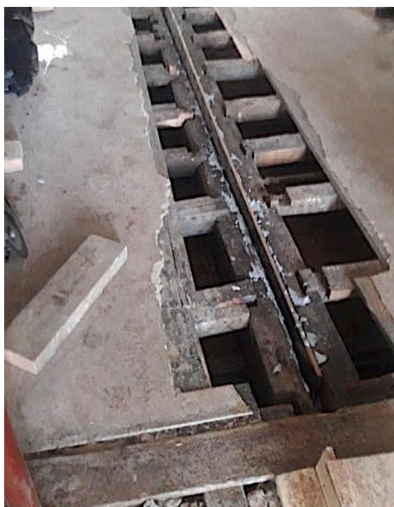
Afb. 43: Stalen plaat geïncorporeerd in eiken moerbalk langs de bovenzijde, case B.I (Origin, 2019).
