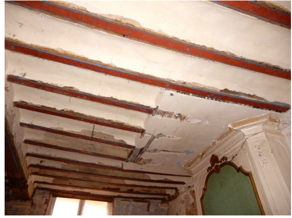
Bijlage afb. 16: Woning 8, niv. 1, tijdens interventie, toevoegen van stalen platen onderaan kinderbalken en moerbalk; aansluiting met monumentale schouw (Triconsult, 2017).
