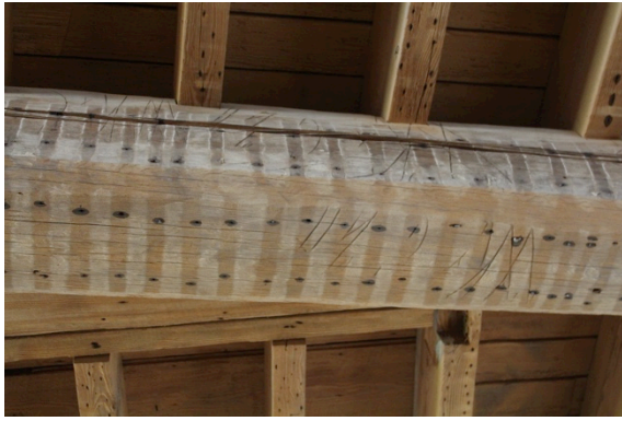
Afb. 79: Depot van kristalfabriek Val-Saint-Lambert Oude Graanmarkt 5, Brussel, 1854. Telmerken op moerbalken boven de eerste verdieping (auteur, 2015)
