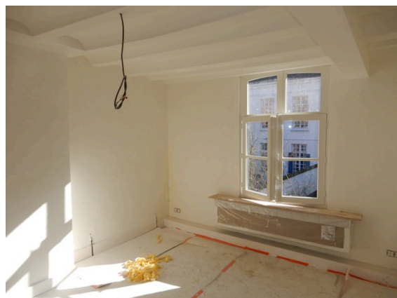
Bijlage afb. 7: Woning 12, niv. 2, nieuwe toestand, na restauratie van het pleisterwerk. De verstevigingen gebeurden bovenaan, op zolder. (Triconsult, 2017).
