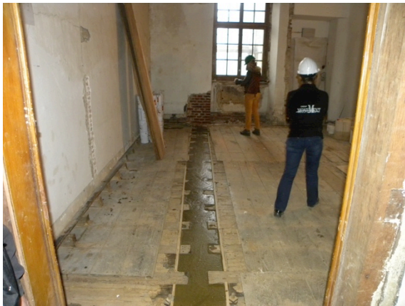
Bijlage afb. 56: Opgieten van epoxymorteluitvulling op een moerbalk van vloer niv. 1. De kinderbalken zijn mee opgenomen voor extra stijfheid van de draagvloer. De hoogte van de epoxylaag is beperkt dankzij het verlagen van de in te rekenen mobiele belasting t.o.v. de norm (Triconsult, 2014).
