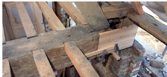
Afb. 20: Tijdens interventie: verlijmde houten balkkopprothese in deels gedemonteerde gevel. (Domus tech (2017))
