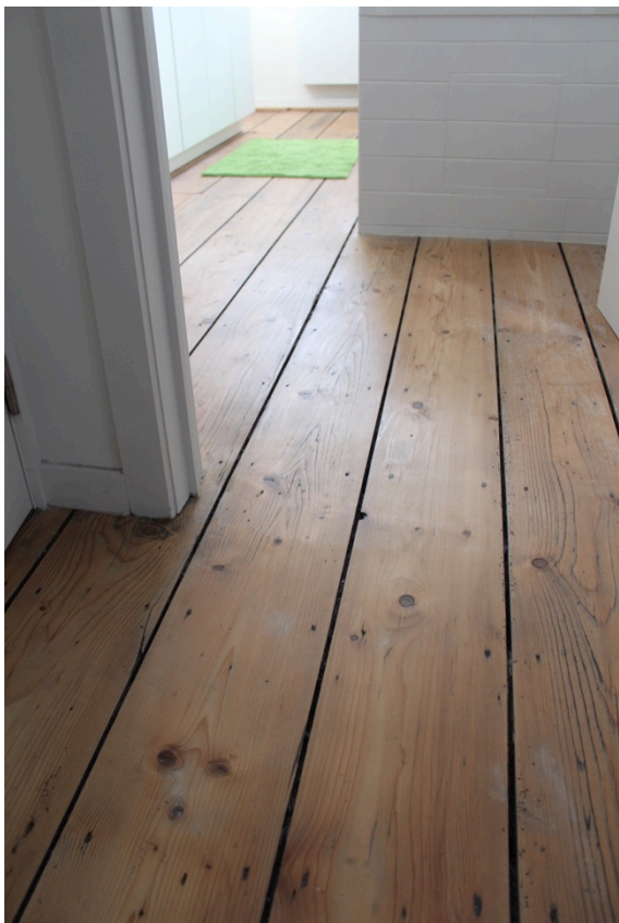
Afb. 76: Verdiepingsvloer met lange brede eikenhouten planken, zeer gaaf bewaard. Gang naar badkamer. Voormalige Berg van Barmhartigheid, Antwerpen (auteur in kader van beheersplan door Maat_werk architecten, 2017)
