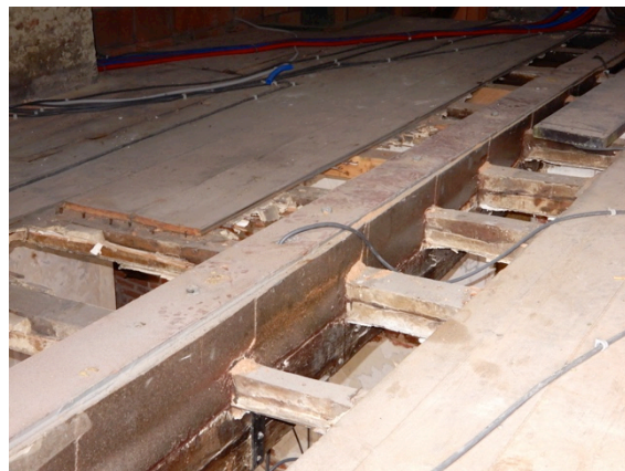
Bijlage afb. 5: Woning 12, vloer niv. 2, tijdens interventie, epoxymorteluitvulling en toevoegen van stalen plaat bovenaan de moerbalk (Triconsult, 2017).
