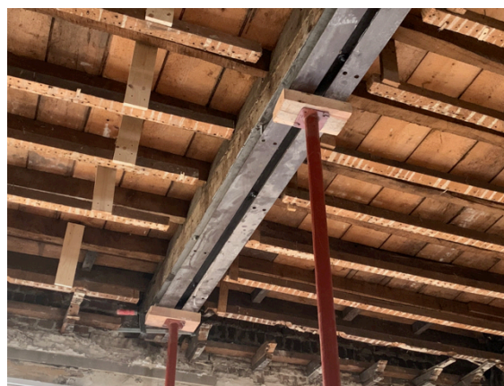
Bijlage afb. 42: Moerbalk gestut op onderliggende reeds verstevigde moerbalk. Gaten voor bevestiging van de M12-bouten, geschrinkt om de 50 cm (DDS+, 2019).
