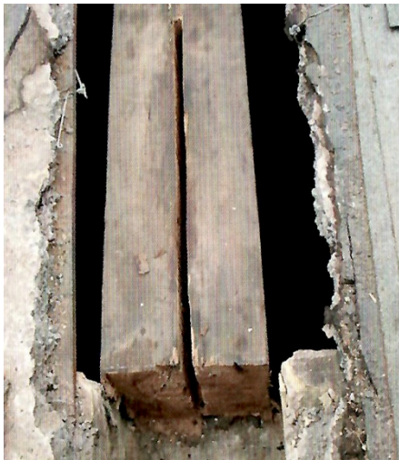
Afb. 45: Start van gefreesde sleuf in bestaande moerbalk (McCaig, l., 2013, p. 308).
