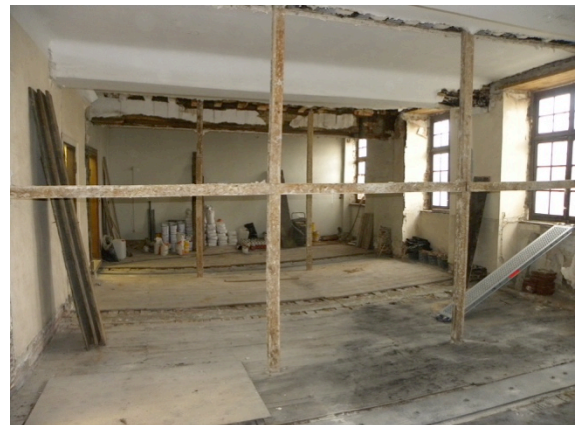
Bijlage afb. 59: De metselwerkinfilling van de tussenwanden werd tijdelijk verwijderd voor de werken aan vloer niv. 1. (Triconsult, 2014).
