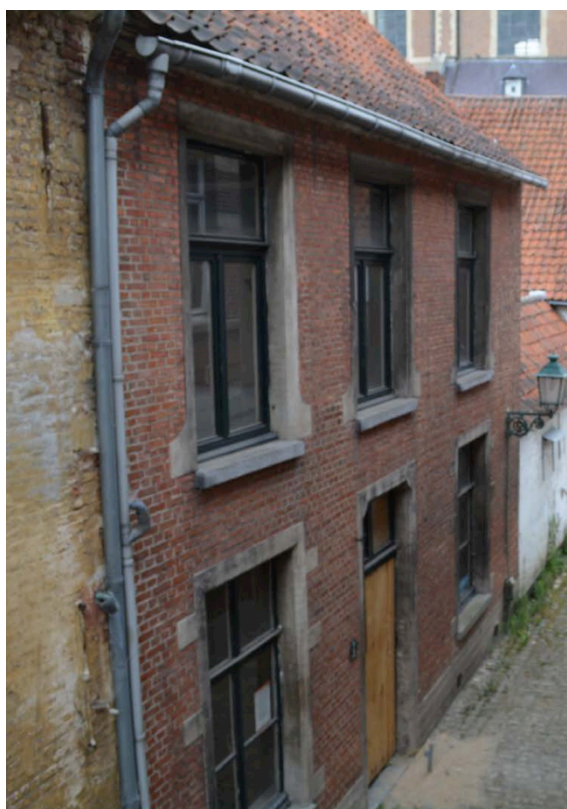
Bijlage afb. 22: Woning 2, bestaande toestand, voorgevel (BVdW & Sumproject, 2017).
