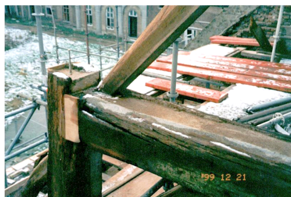
Afb. 26: Stap 3: polymeerchemisch herstel: epoxy in de balk gegoten, de wapening omhullend. (Heirman, G., p.301)
