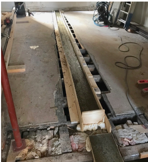
Bijlage afb. 37: Stap 3: opgegoten epoxy in bekisting, de staalplaat omhullend. De kinderbalkkoppelen zijn mee opgenomen in de epoxymortel voor extra stijfheid van de vloer (Origin, 2019).
