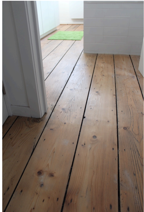
Afb. 4: Verdiepingsvloer met lange brede eikenhouten planken. Voormalige Berg van Barmhartigheid, Antwerpen (auteur in kader van beheersplan door Maat_werk architecten, 2017).
