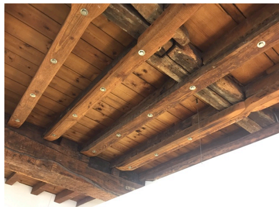
Afb. 35: De houten secties zijn bevestigd met bouten over een regelmatige afstand. Kartuizerstraat 31, Brussel (auteur, 2019).
