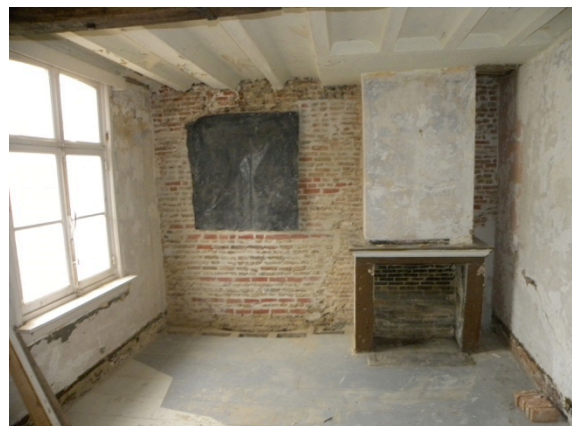
Bijlage afb. 3: Woning 12, niv. 1, bestaande toestand, ontleisterde moorbalk en bepleisterde kinderbalken met troggewelven (Triconsult, 2010).
