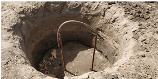
FIGUUR 42: DE PUT VOOR DE KABELFUNDERING MET HET WAPENINGSIJZER
