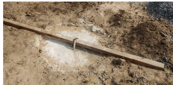
FIGUUR 43: DE KABELFUNDERING NADAT HET BETON GEGOTEN IS
