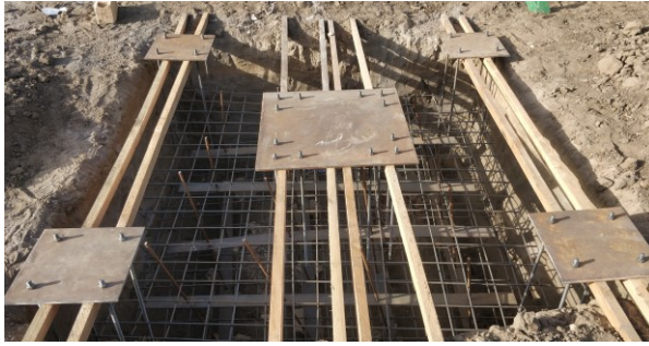
FIGUUR 35: DE WAPENING VAN DE FUNDERING
