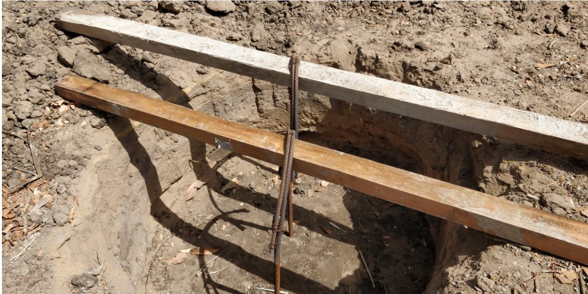
FIGUUR 44: DE WAPENING VAN DE KABELFUNDERING WAAR DE KATROL AAN BEVESTIGD WORDT
