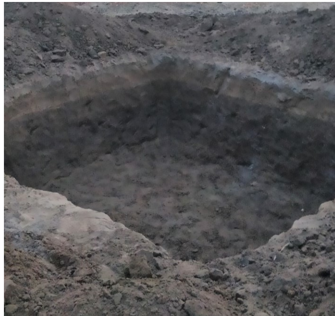
FIGUUR 32: DE PUT VOOR DE FUNDERING
