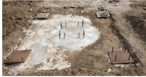
FIGUUR 36: DE AFGEWERKTE FUNDERING
