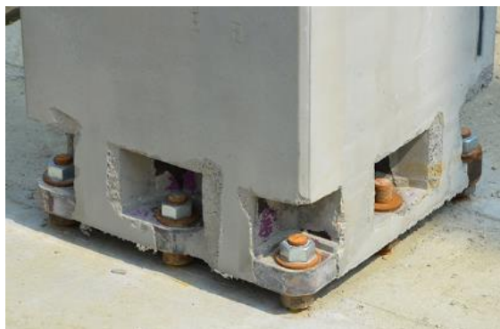
Figuur 18: Verbinding kolom – fundering (Peikko, 2020)
