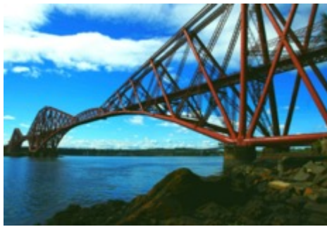
Figuur 28: Forth Bridge. Overgenomen uit pixabay.com
