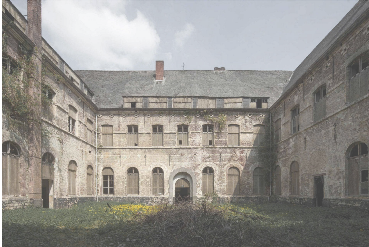
Afb. 39 Het klooster voor de restauratie
