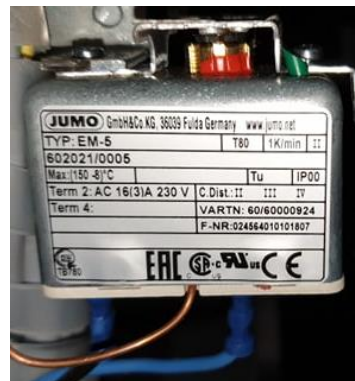
Figuur 133: Het contact van de overtemperatuurbeveiliging
