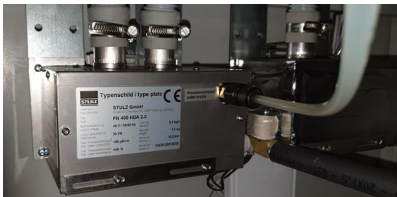
Figuur 130: De ultrasoonbevochtiger met zijn watertoevoer en magneetventiel
