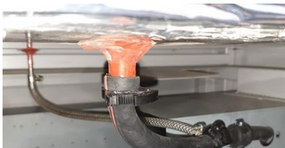
Figuur 135: De waterafvoerleidingen
