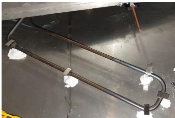
Figuur 134: De elektrische weerstand en zijn overtemperatuurbeveiliging
