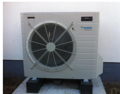
Figuur 1: Lucht - luchtwarmtepomp
