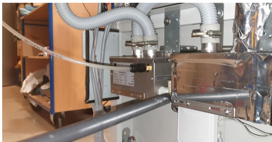
Figuur 129: Het inbouwen van de bevochtiger en zijn ventilobox
