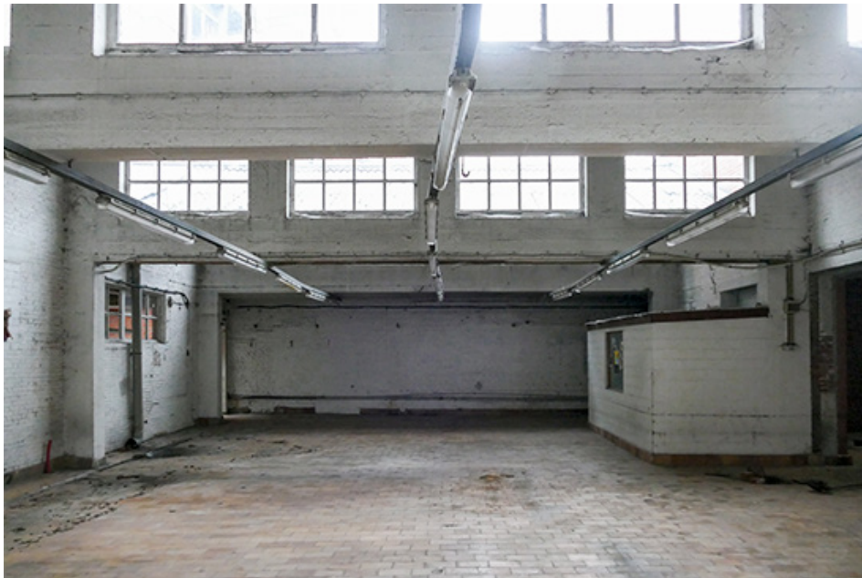
Voormalige werkhal met sheddak
