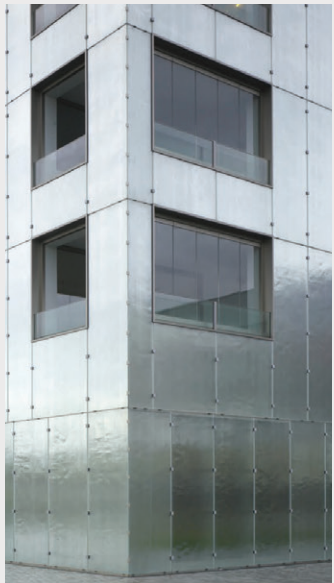
Afb. 4.2.8. Aluminium panelen achter kathedraalglas ©Diener Diener
