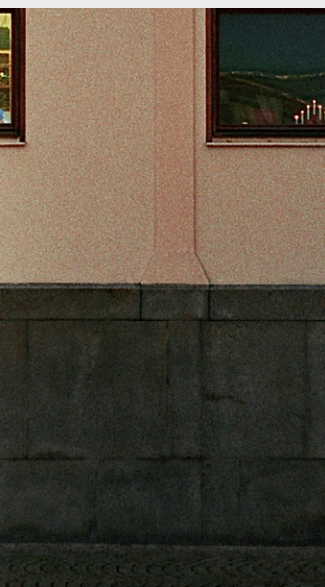
Afb. 2.2.16. Gepleisterde kolom steunt op natuursteen ©Thibault De Smet
