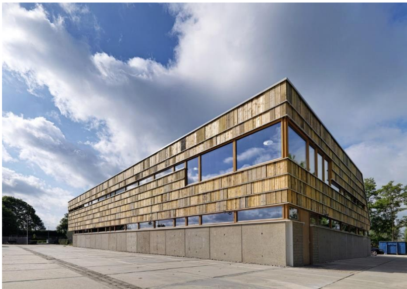
Figuur 18: De gevel van de kringloopwinkel in Houten, Nederland (Lachmeijer, 2018)
