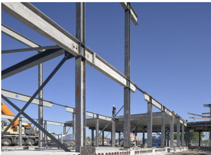
Figuur 9c: Het gebouw van Biopartner 5 met de staalconstructie van het Gorleaus laboratorium (Bouwwereld, z.d)
