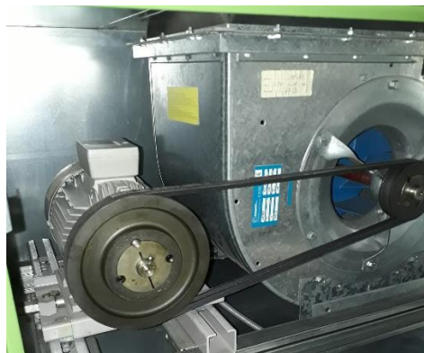
Figuur 4-3 Aandrijving ventilator luchtgroepen
