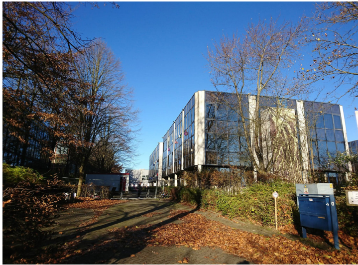
Fig. 24: Extérieur opvangcentrum Zaventem
