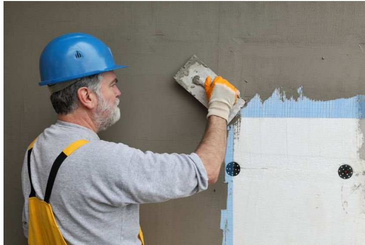
Figuur 10: Pleisterlaag ETICS-systeem (Crep-info,2021)
