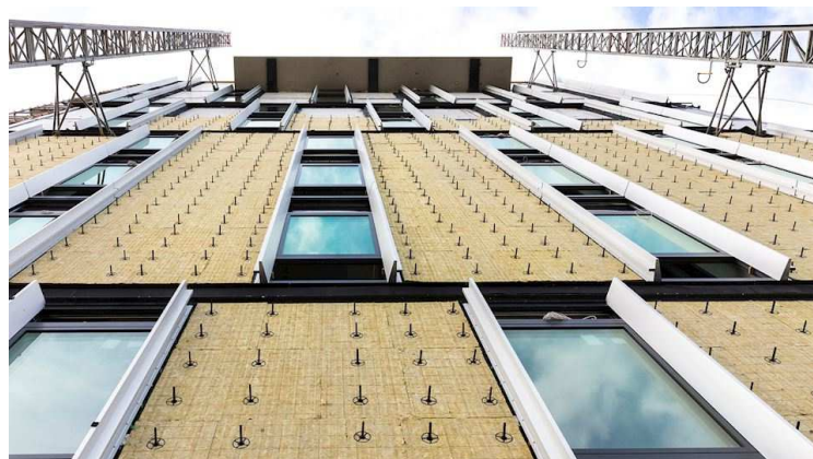
Figuur 13: Montage gordijngewel met glas en invulpanelen (Rockwool, 2021)
