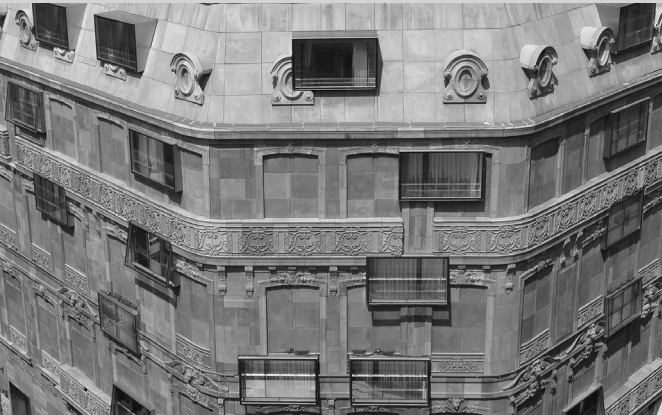
► (fig. 42) Hotel Fouquet van Maison Edouard François. De betonnen constructie is een afdruk/kopie van de klassieke Haussmanniaanse blokken in Parijs. De inwendige structuur en ramen volgen niet de klassieke opbouw en breken letterlijk met de gevel.
