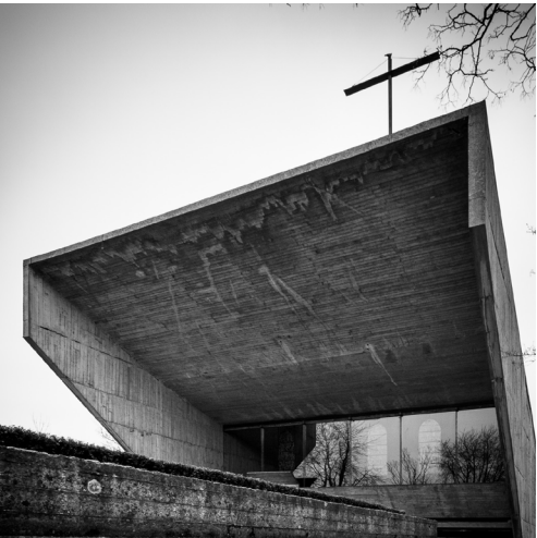
▲ (fig. 74) De bedevaartskerk te Kerselare, naar het ontwerp van architect Juliaan Lampens.
