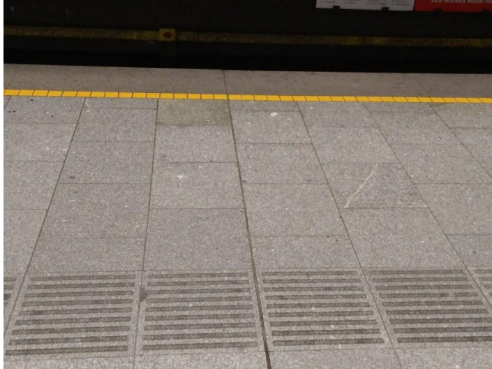
Illustratie 15: Tactiele surfaces aan het perron 9
