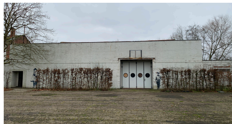
Afbeelding 58: Gebouw G en binnenplein (eigen data, 2022)
