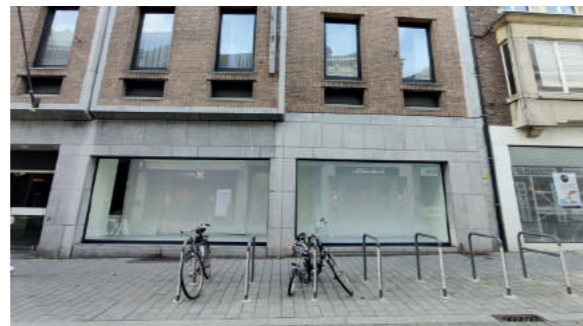
Fig. 47: De fietsenstalling die voor een etalage staat waardoor de mensen en de passerende bus moet uitwijken
