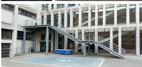
Campus Dunant Dunant 2 - Gewapend Beton - Baksteen Balk- en kolomsysteem
