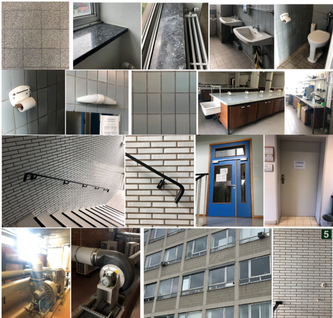
Figuur 25: Overzicht herbruikbare materialen bestaand gebouw UZ Blok B (ROTORDC, 2021; Correspondentie DGFB UGent)
