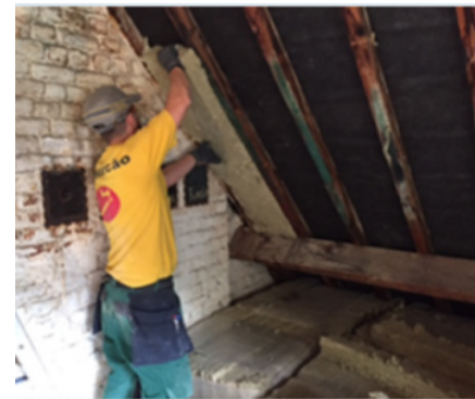
Figuur 14: Ontmantelde scheidingswand en recuperatie van isolatie (FCRBE, 2020; Vanderick, 2019)
