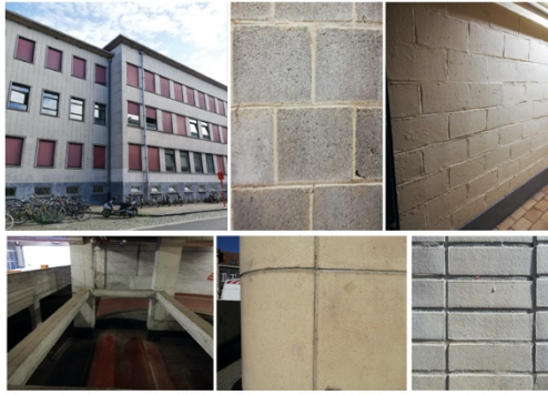
Campus Boekentoren Blandijnberg - Gewapend Beton - Baksteen Balk- en kolomsysteem
