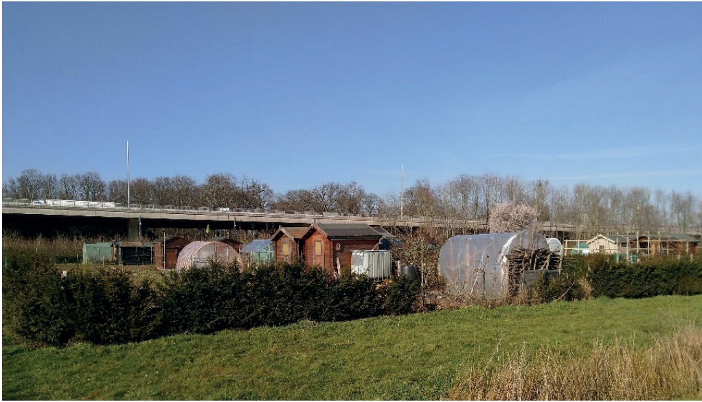
Figuur 7-3: Het volkstuintuincomplex in Gentbrugge is gesitueerd naast het E17-viaduct.
