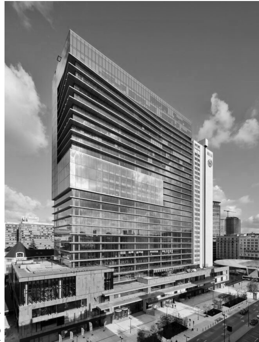
(fig. 6) Het Manhattan Center na de renovatiewerken
