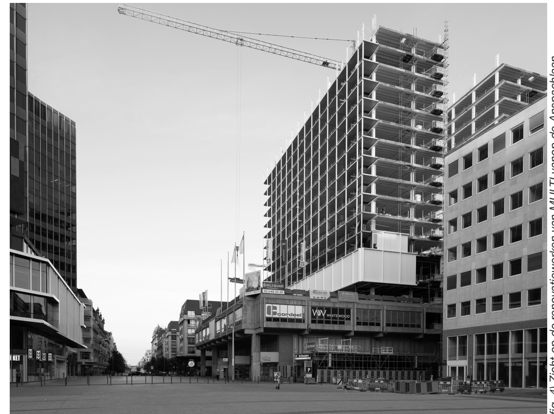
(fig. 4) Zicht op de renovatiewerken van MULTI vanop de Anspachlaan
