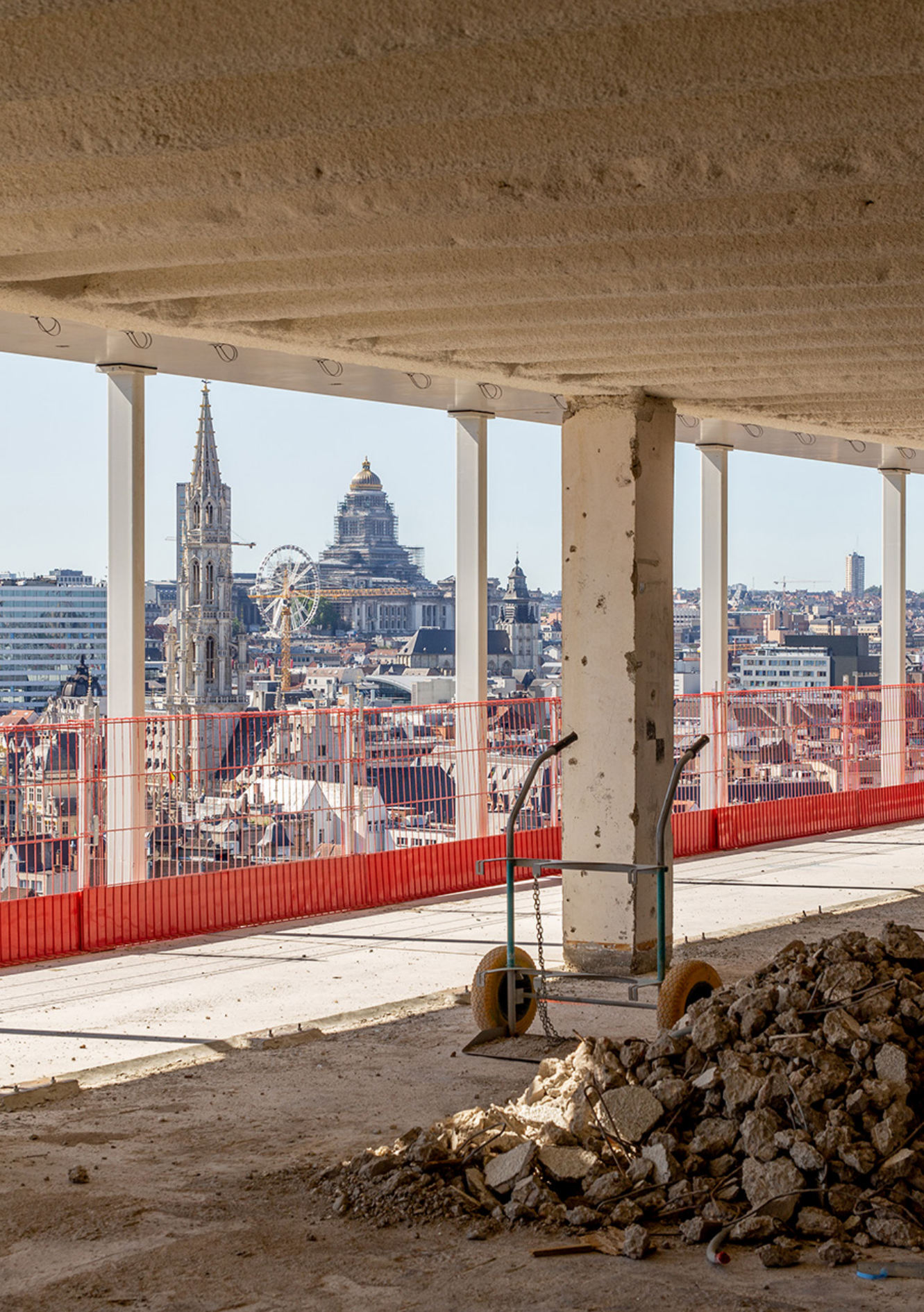
(fig. 2) Beeld gedurende de renovatie van MULTI met uitzicht over Brussel
