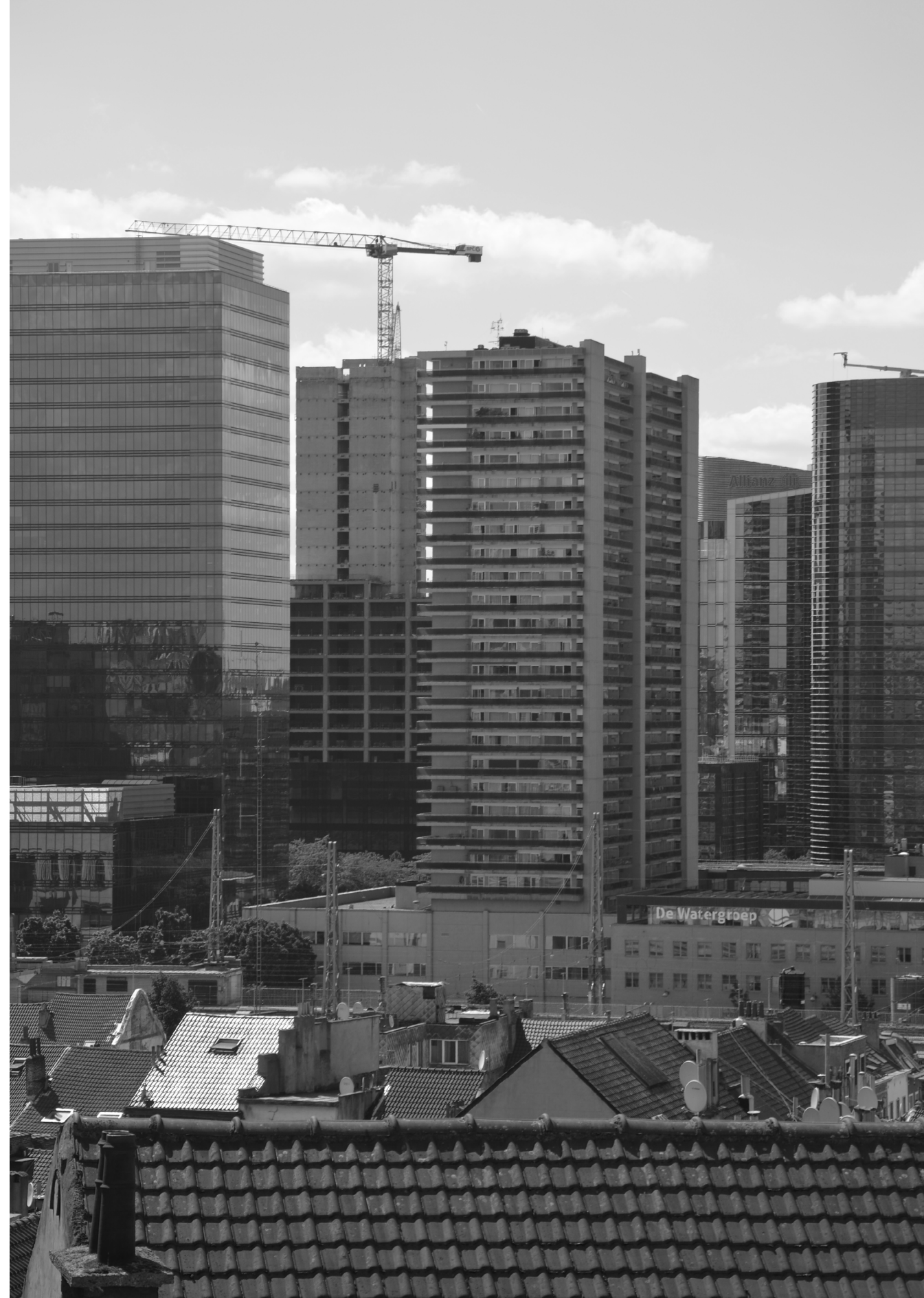
(fig. 65) Uitzicht vanuit de faculteit op de bouwwerken van ZIN
