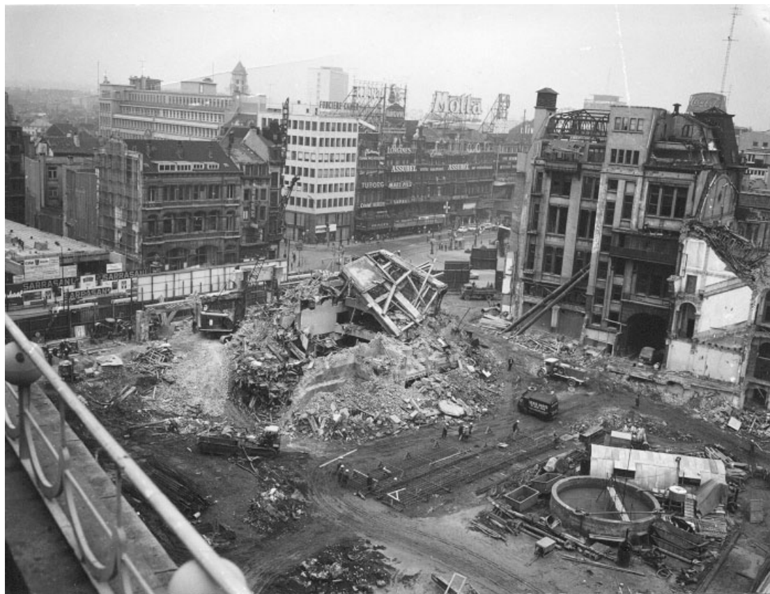
(fig. 3) De afbraak voor de bouw van de Philipstoren
