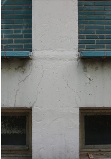
Figuur 17: Bekistingsvoeg zichtbaar in het gevelbeeld (eigen afbeelding)
