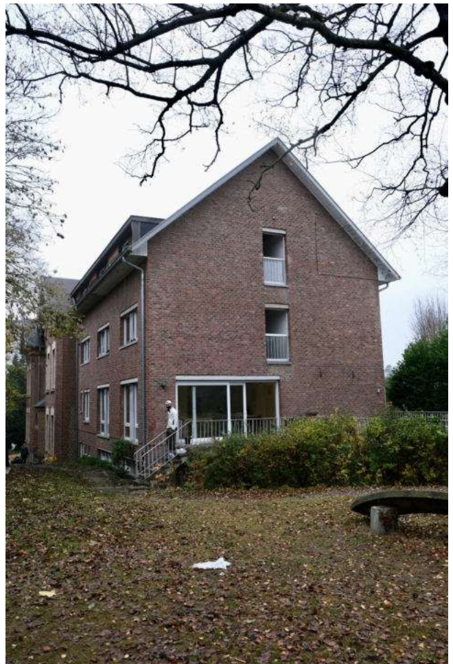
Fig. 8 Backyard in Oudergem.
