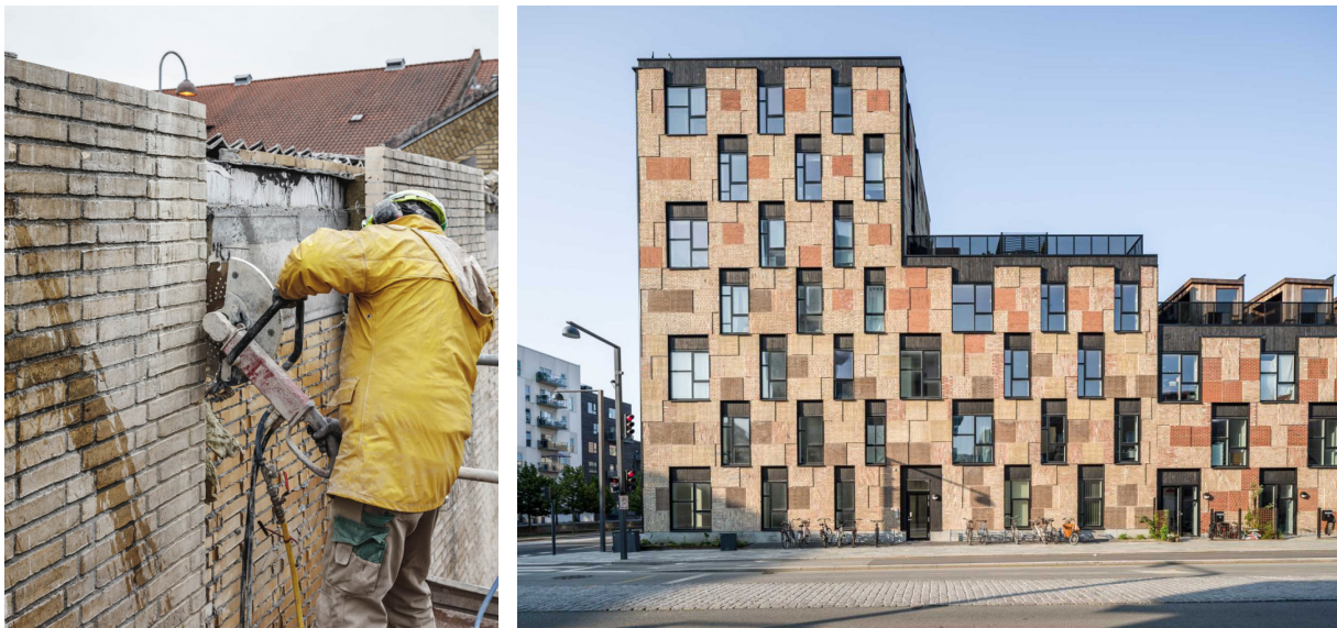
Figuur 23: Foto van het uitsnijden van metselwerkmodules voor het project Resource Rows met ernaast een foto van het project zelf van Lendager Group (Lissalde, 2022)
