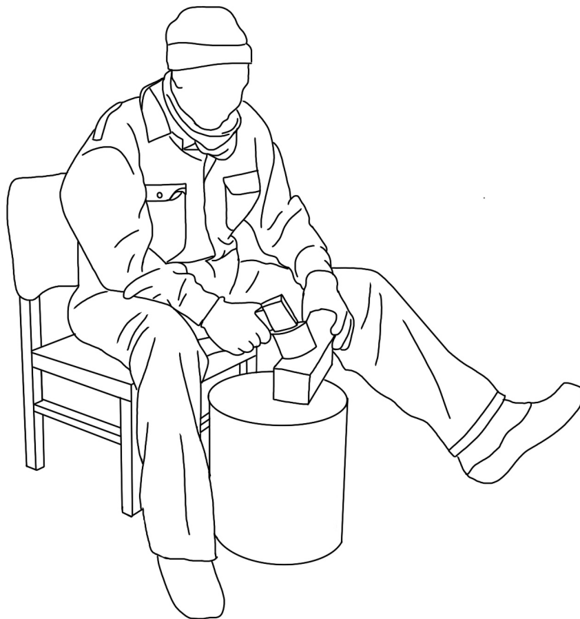
Figuur 34: Handmatig kuisen van de baksteen met een beitel
