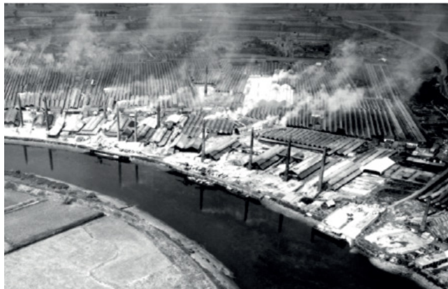
Figuur 17: Luchtfoto genomen tussen 1962 en 1965 van het gehucht Noeveren in Boom. Rechthoekige Hoffmannovens, elk met een capaciteit van 1,2 miljoen stenen, zijn verbonden met een schoorsteen. Om het continue bakproces gaande te houden was per oven 8 à 9 km aan droogloodsen nodig. Op de foto zijn ook enkele klampovens te zien (Le Noir, 2017).
