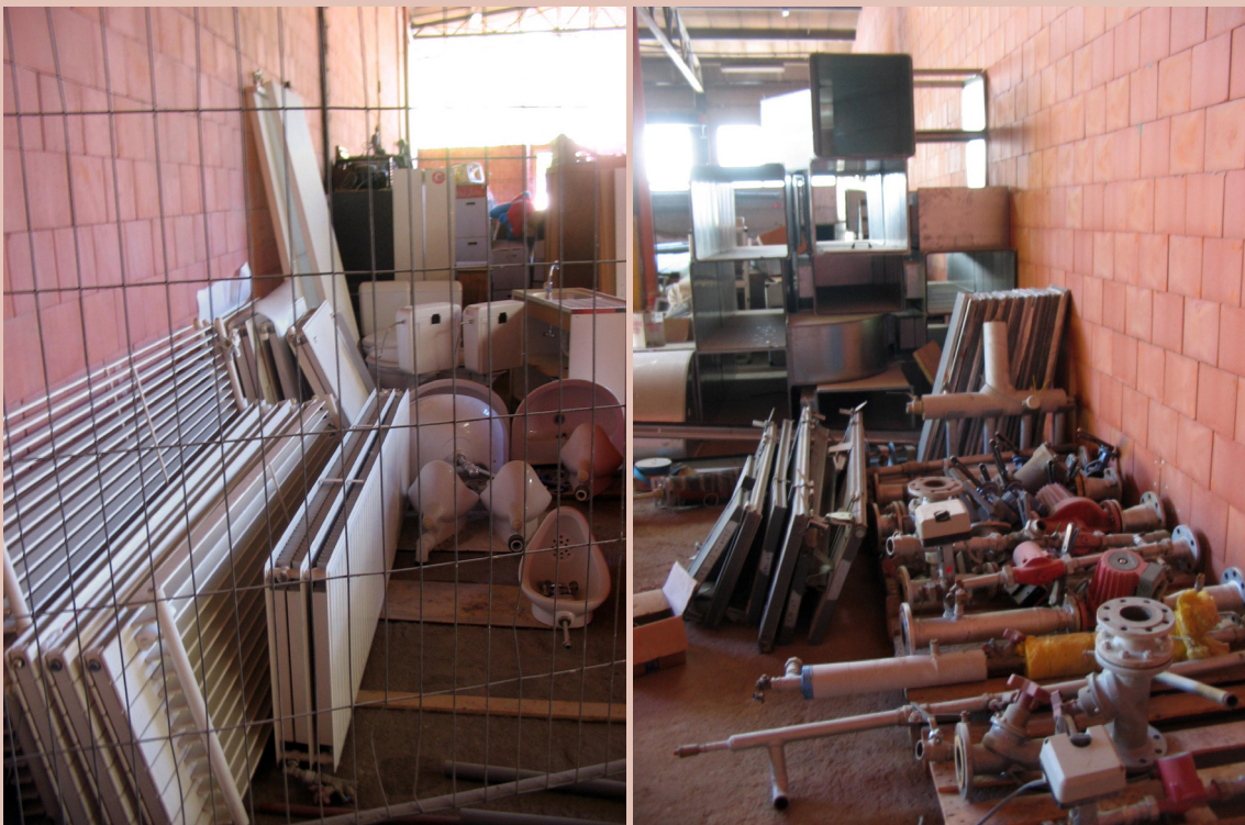
Figuur 8: Renovatieproject Maison des Associations in Esneux, waarbij een zorgvuldige ontmanteling plaatsvond voor alle elementen geschikt voor hergebruik. Deze elementen werden dan opnieuw ter plaatse toegepast (Vlaanderen Circulair, 2017).
