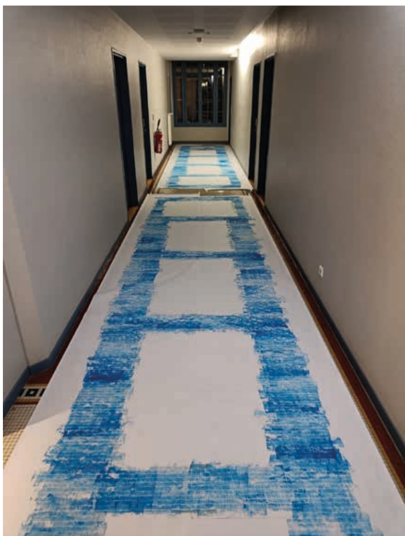
VI. De nachtelijke werkopstelling in de gang van de derde verdieping van de FBL.
