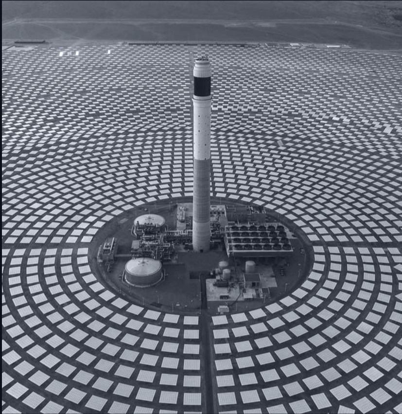
III. De concentrisch geplaatste spiegels van het Nour-Ouarzazatecomplex in Marokko bundelen de zonnestralen in de centrale kolom, die de verzengende hitte omzet in elektrische energie. De energie uit centrales zoals deze kan vervolgens ingezet worden in de productie van groene waterstof.
