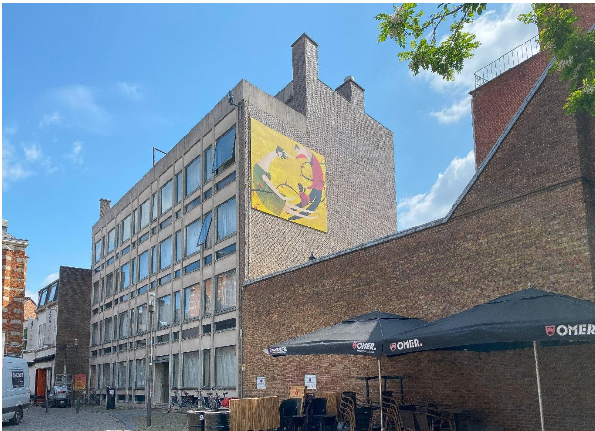
Figuur 45. Voorgevel Oude Dekenij. (eigen figuur, 2023)
