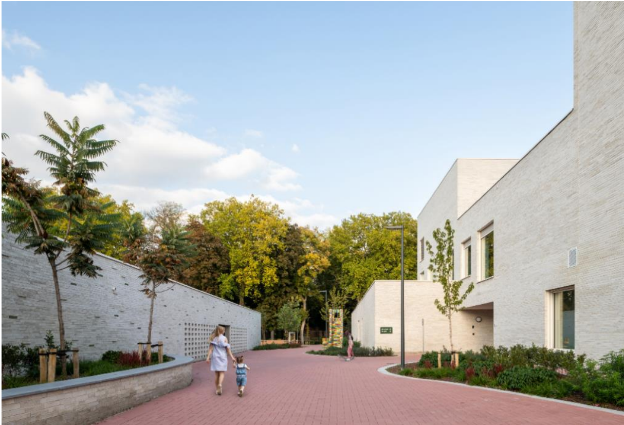
Figuur 22. Publieke doorsteek De Korbeel Kortrijk. (VK Architects, 2023)
