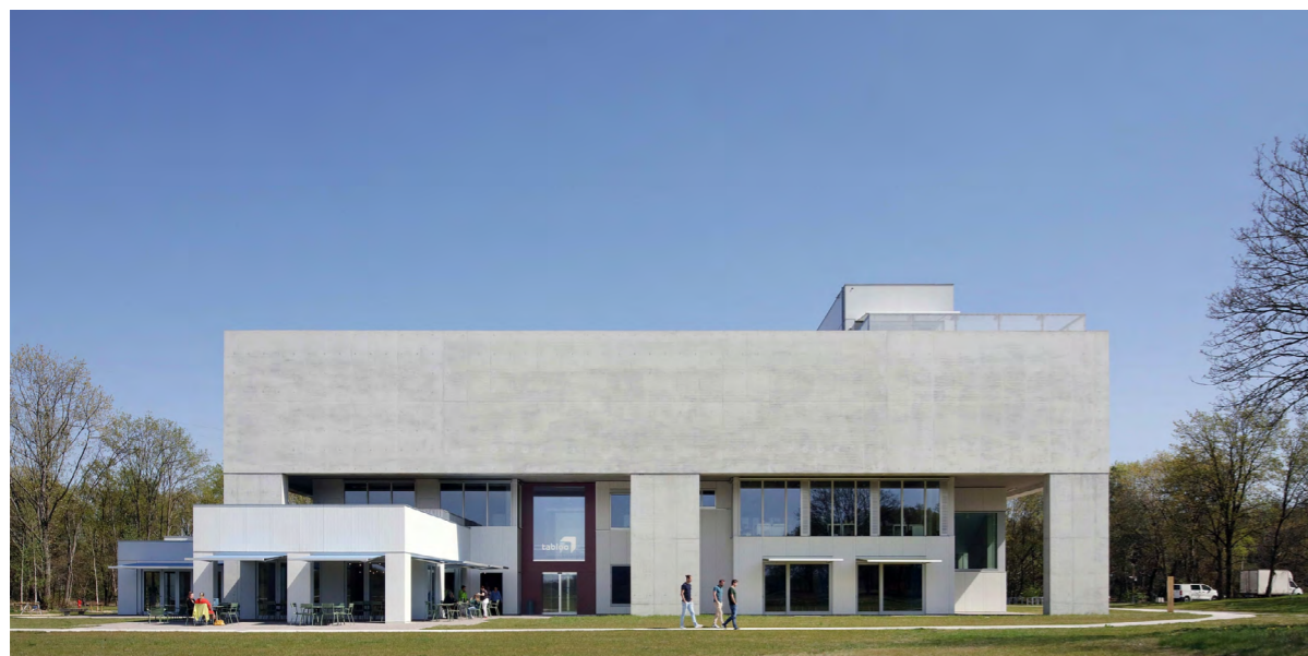
Communicatiecentrum Tablo, Bovenbouw en Onno architectuur - een bewuste omgang met de relatie tussen materialiteit en tijd.
