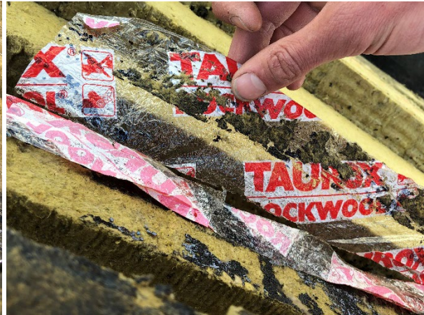
Afb. 51 (links): Overblijfsel van een etiket van de aanwezige rotswoolisolatie Afb. 52 (rechts): Overblijfsel van de wegbrandfolie van de aanwezige rotswoolisolatie
