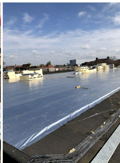
Afb. 56 (links): Arbeiders die PIR-isolatie plaatsen na het verwijderen van de rotswoolisolatie Afb. 57 (midden): PVC dakbedekking aangebracht op de geplaatste PIR-isolatie Afb. 58 (rechts): Container met rotswool, bitumineuze dakdichting en ander plastic afval van de werf
