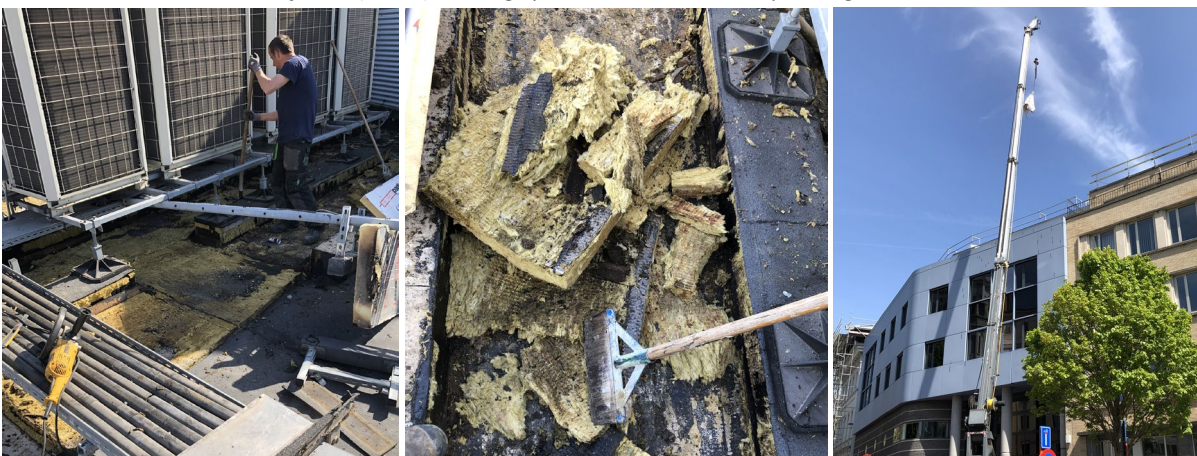
Afb. 19 (links): Slijpschijf op de voorgrond en arbeider die isolatie losmaakt met een schop
