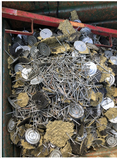
Afb. 53 (links): Slijpschijf op wielen om de dakbedekking mee door te zagen Afb. 54 (midden): Verzamelde mechanische bevestigingen na het verwijderen uit de isolatie Afb. 55 (rechts): Gestapelde isolatieplaten na ontmanteling en 4 verzamelde stalen
