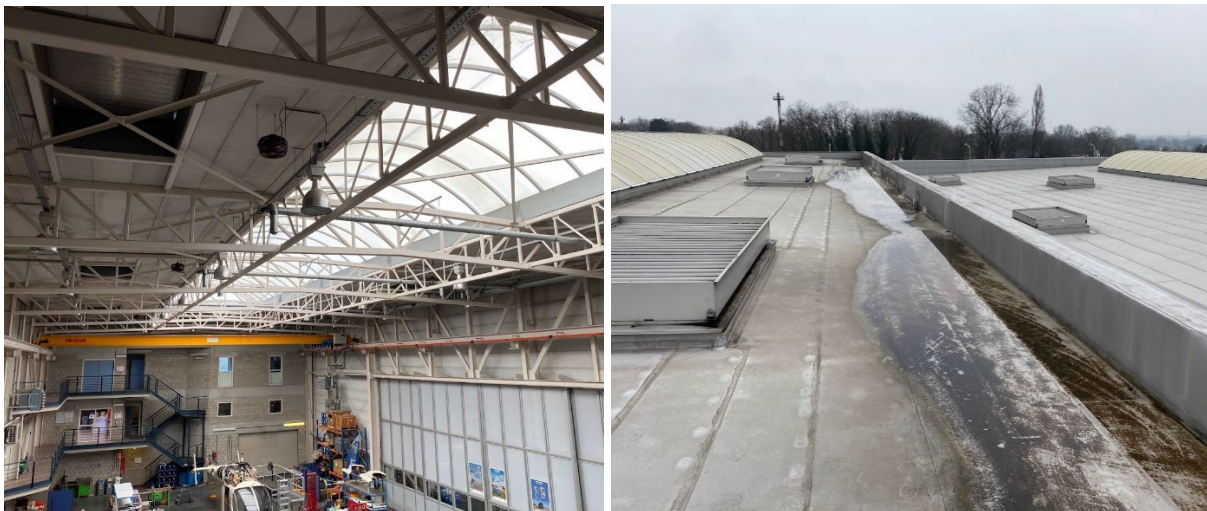
Afb. 11 (links): Stalen structuur met opgelegde cellenbeton dakvloer van Dak 1.
