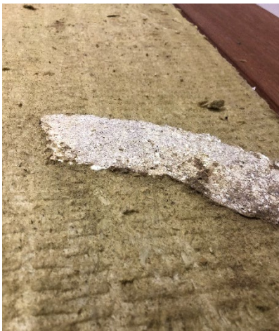
Afb. 36 (links): Schade aan de toplaag van de isolatie door het verwijderen van de dakdichting
