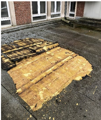
Afb. 33 (links): Bitumineuze dakdichting van de isolatie getrokken
