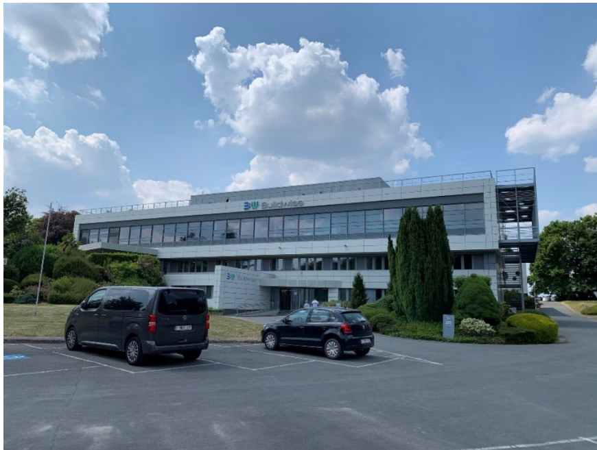
Afb. 83 : Testcentrum van Buildwise in Limelette, België
