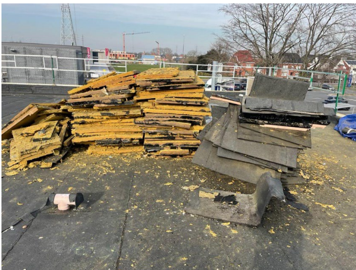
Afb. 5: Foto na het ontmantelen van isolatie en roofing
