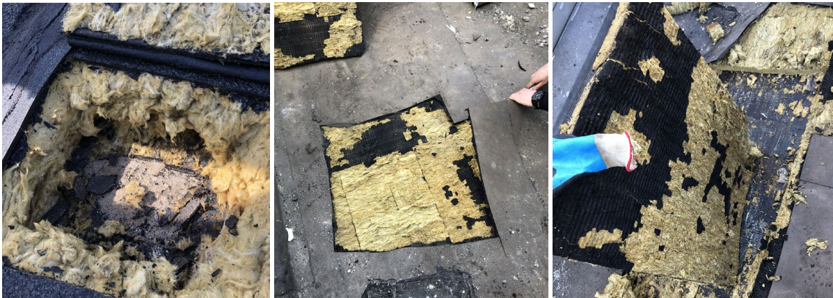
Afb. 16 (links): Insnijding in de dakopbouw
