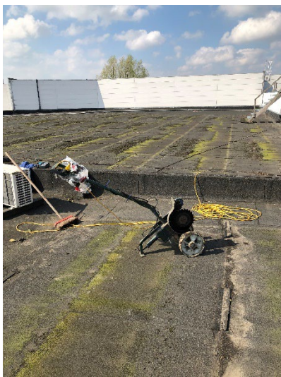
Afb. 53 (links): Slijpschijf op wielen om de dakbedekking mee door te zagen Afb. 54 (midden): Verzamelde mechanische bevestigingen na het verwijderen uit de isolatie Afb. 55 (rechts): Gestapelde isolatieplaten na ontmanteling en 4 verzamelde stalen
