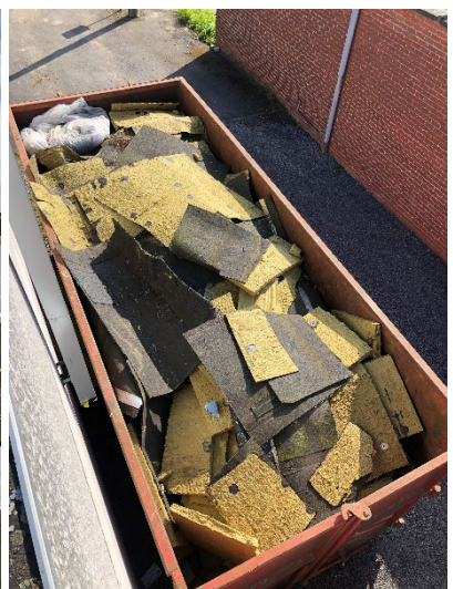
Afb. 56 (links): Arbeiders die PIR-isolatie plaatsen na het verwijderen van de rotswoolisolatie Afb. 57 (midden): PVC dakbedekking aangebracht op de geplaatste PIR-isolatie Afb. 58 (rechts): Container met rotswool, bitumineuze dakdichting en ander plastic afval van de werf
