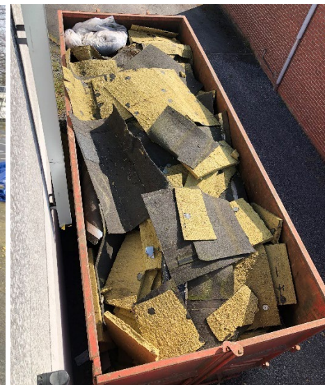
Afb. 6: Rotswol en roofing belanden in container
