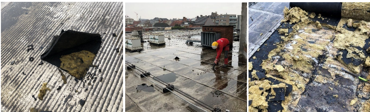
Afb. 42 (links): Rotswol geconstateerd na insnijding in de dakbedekking Afb. 43 (midden): Arbeider die de bitumineuze dakdichting doorsnijdt met een kleine slijpschijf Afb. 44 (rechts): Dak na het verwijderen van twee platen rotswolisolatie
