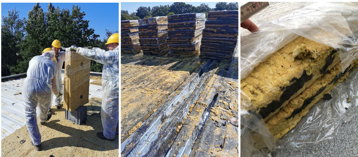
Afb. 8 (links): Rotswolisolatie uit het meest recente dak die met folie ingepakt wordt.
