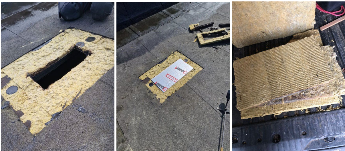
Afb. 46 (links): Dakbedekking verwijderd ter hoogte van de plaats van de herstelling
