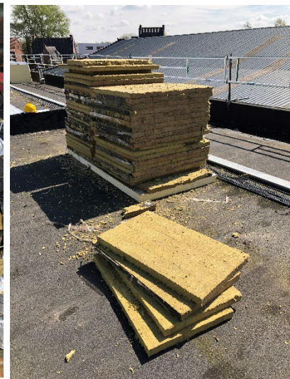
Afb. 53 (links): Slijpschijf op wielen om de dakbedekking mee door te zagen Afb. 54 (midden): Verzamelde mechanische bevestigingen na het verwijderen uit de isolatie Afb. 55 (rechts): Gestapelde isolatieplaten na ontmanteling en 4 verzamelde stalen
