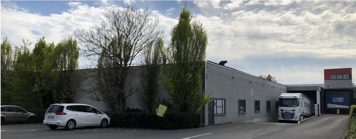
Afb. 49: Foto van de voorzijde van de Label Products site in Waregem
