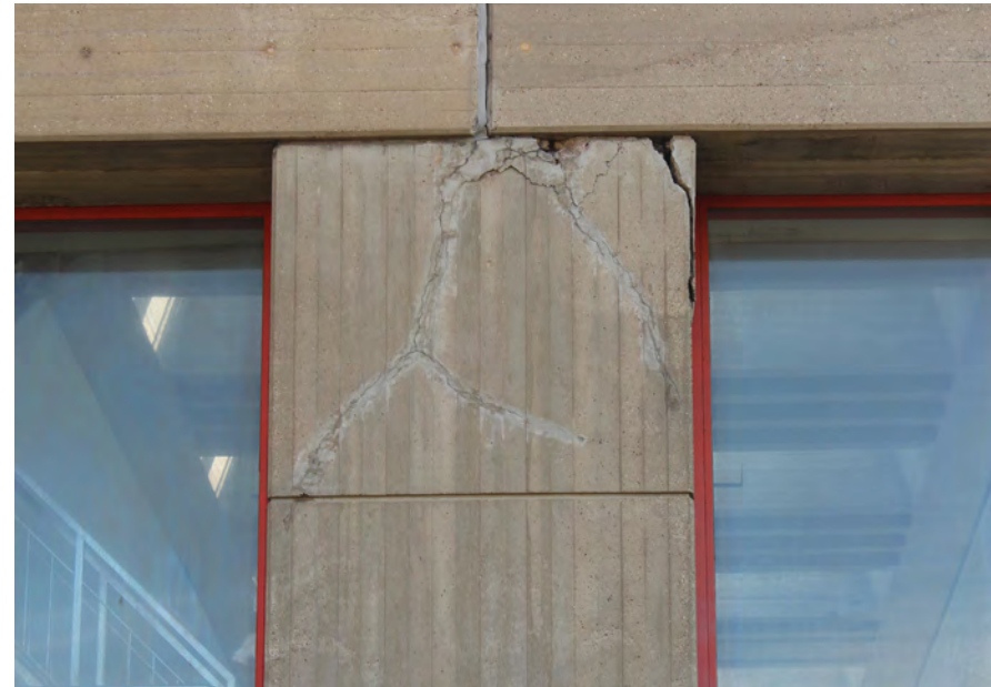
72 Schade kolom zwembadhal
