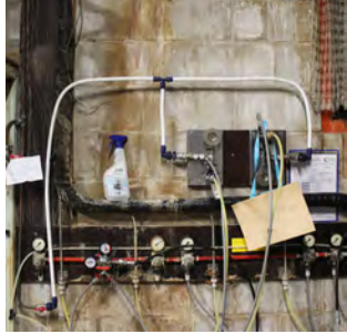
59 Schade aan de wand met betonblokken
