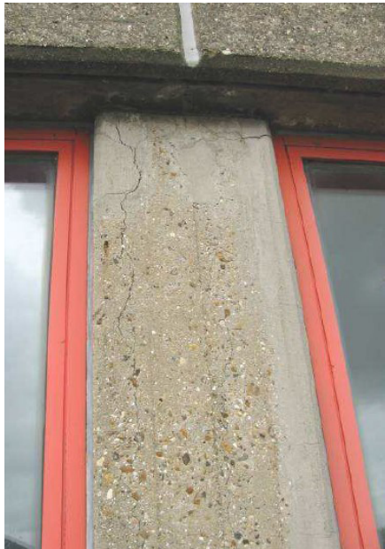
69 Schade betonnen gevelelementen
