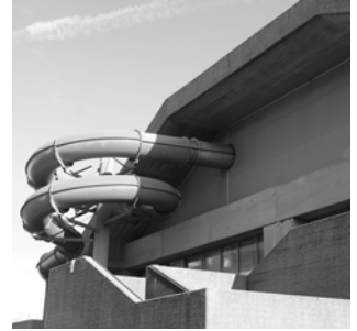
39 Nieuwe glijbaan en zonnewering
