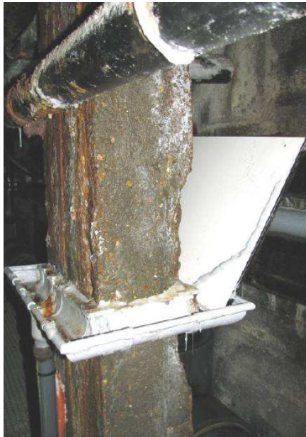
63 Schade kolommen zwembadkuip
