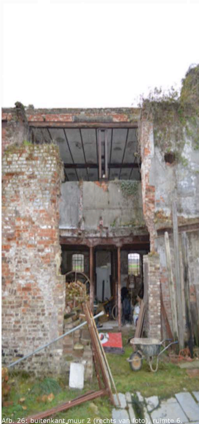
Afb. 26: buitenkant muur 2 (rechts van foto), ruimte 6.
