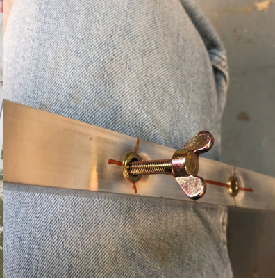
Figuur 3.49: vleugelmoer in aluminium frame
