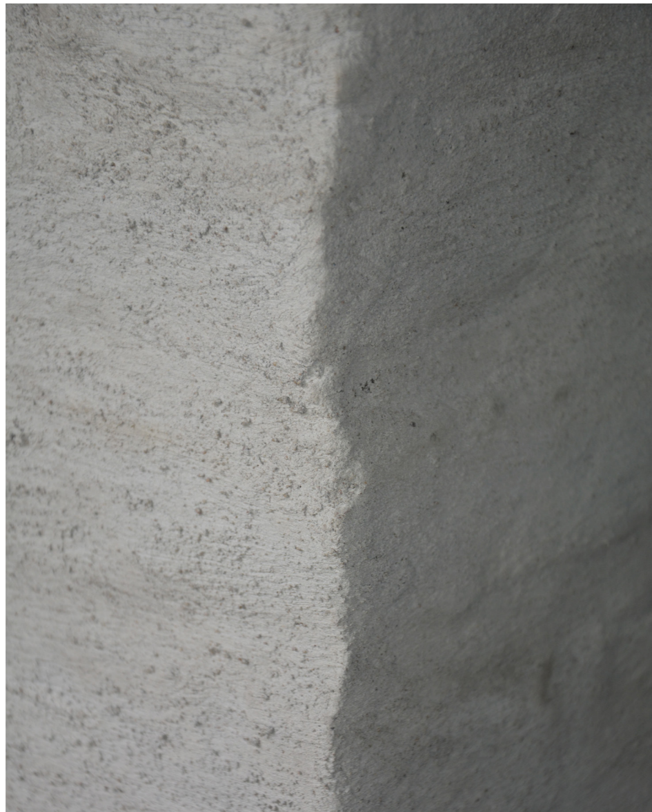
67. Eigen beeld. Kalei techniek.
